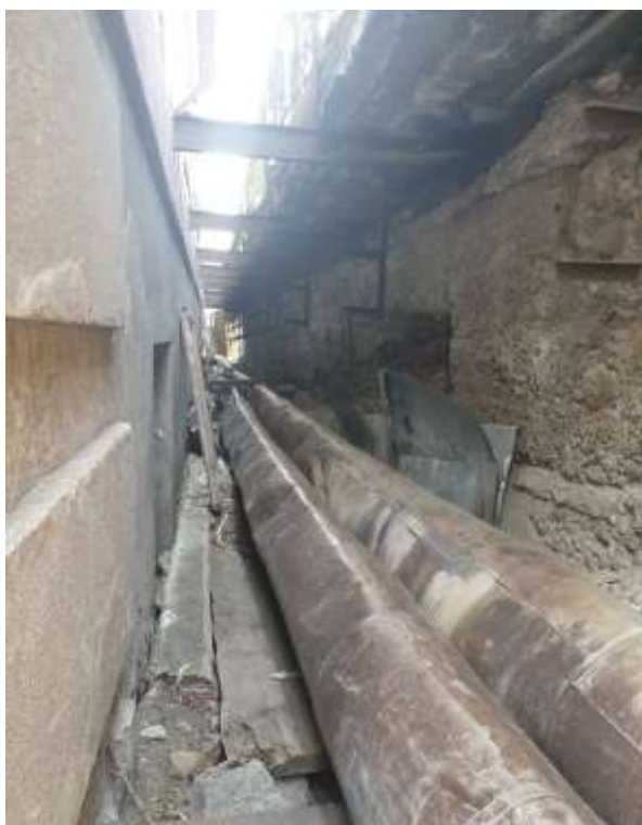
Рисунок 6.4 – Фотография прохождения теплосети вдоль домов № 19, 21 по ул. Советская
