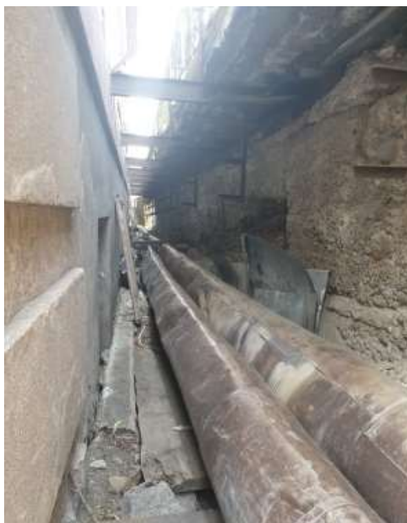
Рисунок 5.4 – Фотография прохождения теплосети вдоль домов № 19, 21 по ул. Советская
