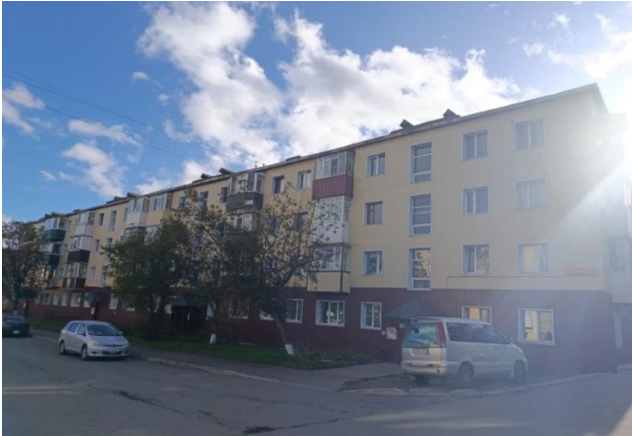
Общий вид здания:
