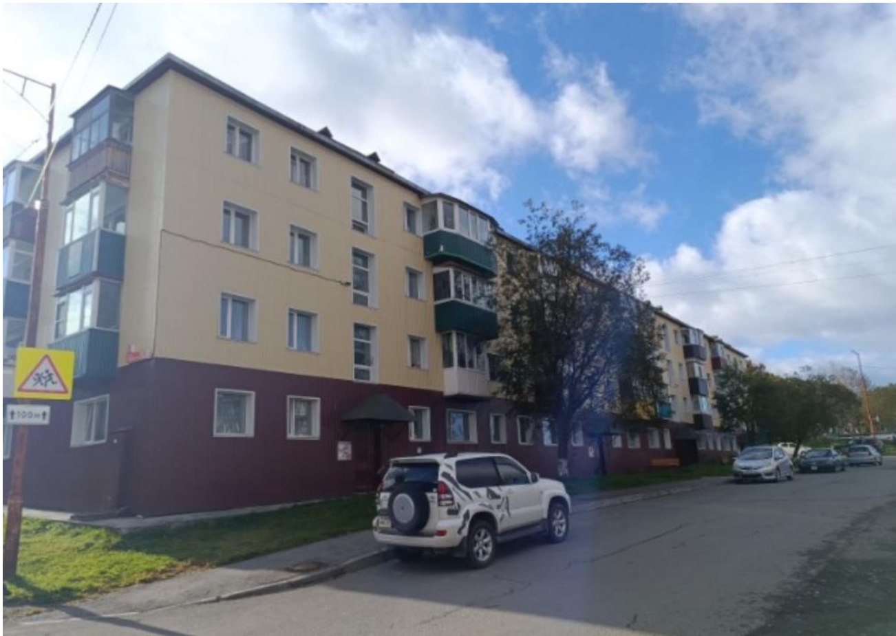
Общий вид здания:
