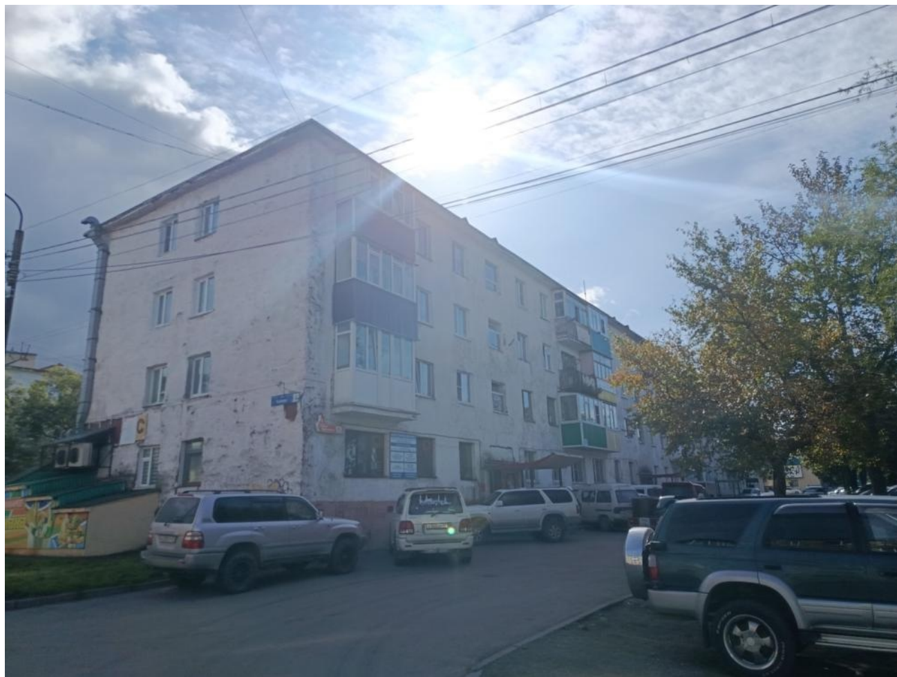
Общий вид здания:
