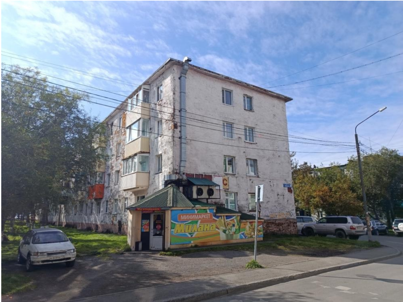
Общий вид здания:
