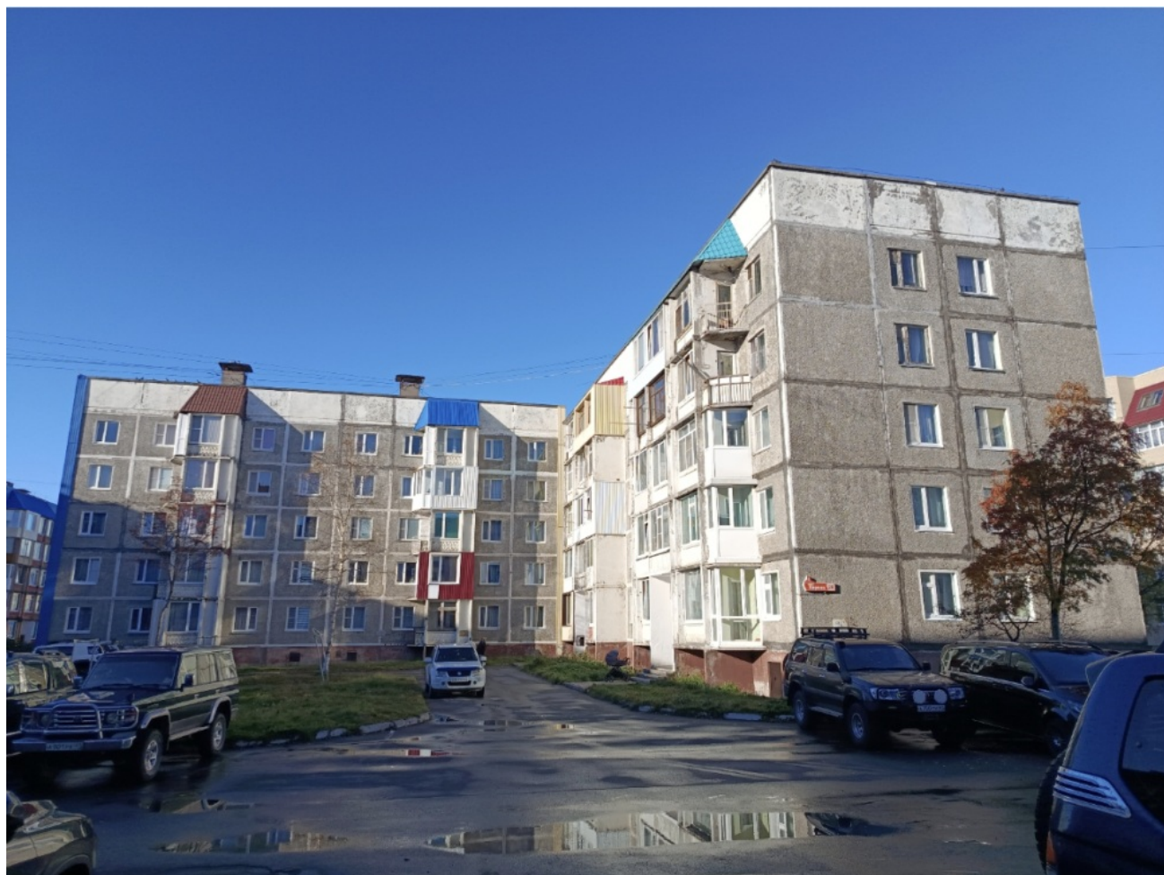
Общий вид здания:
