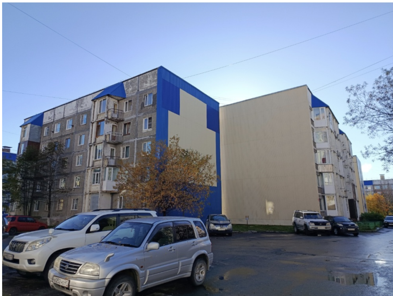
Общий вид здания:
