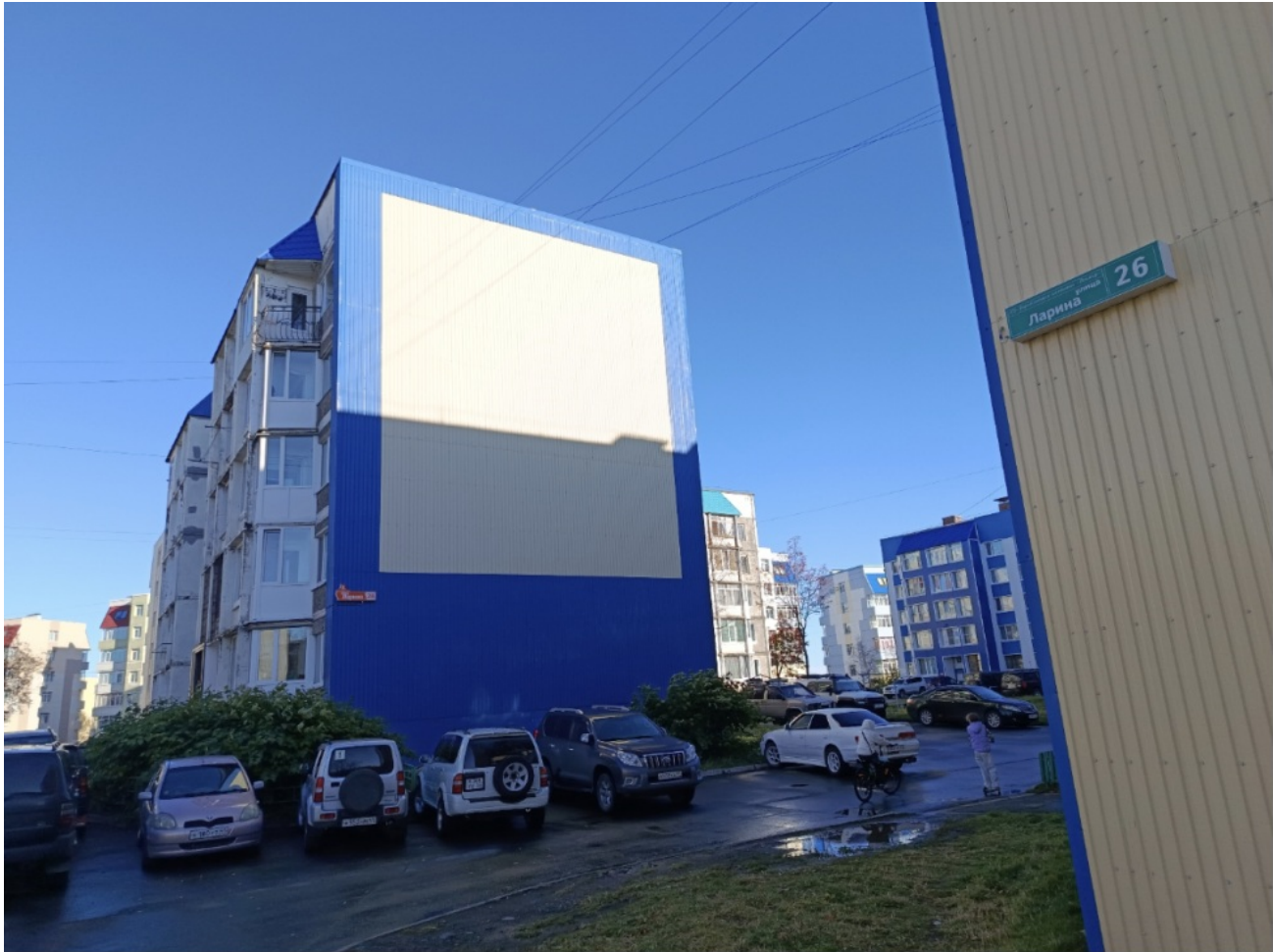
Общий вид здания:
