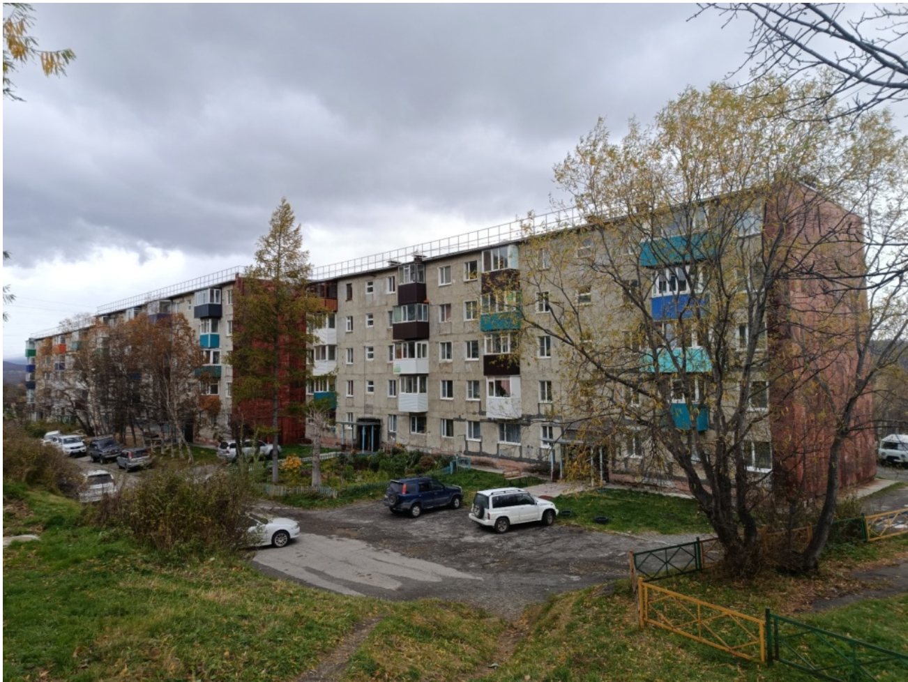
Общий вид здания:
