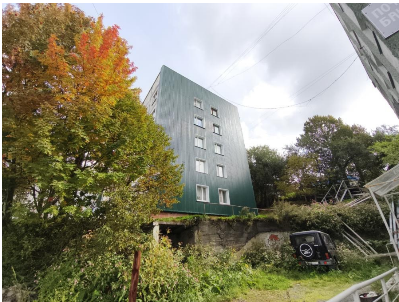
Общий вид здания:
