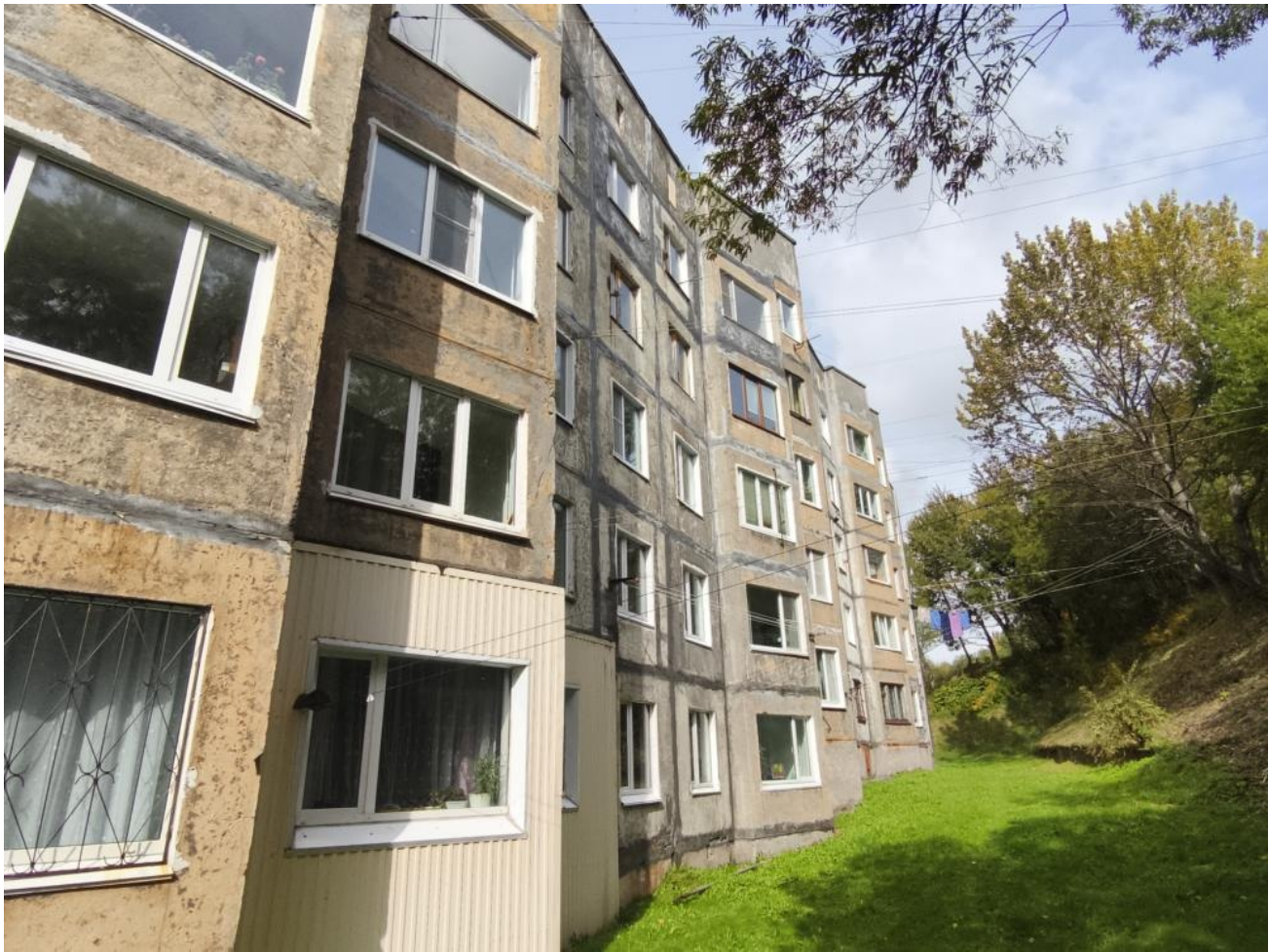
Общий вид здания:
