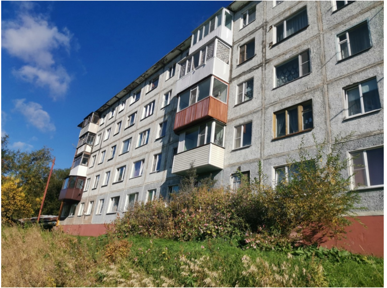
Общий вид здания:
