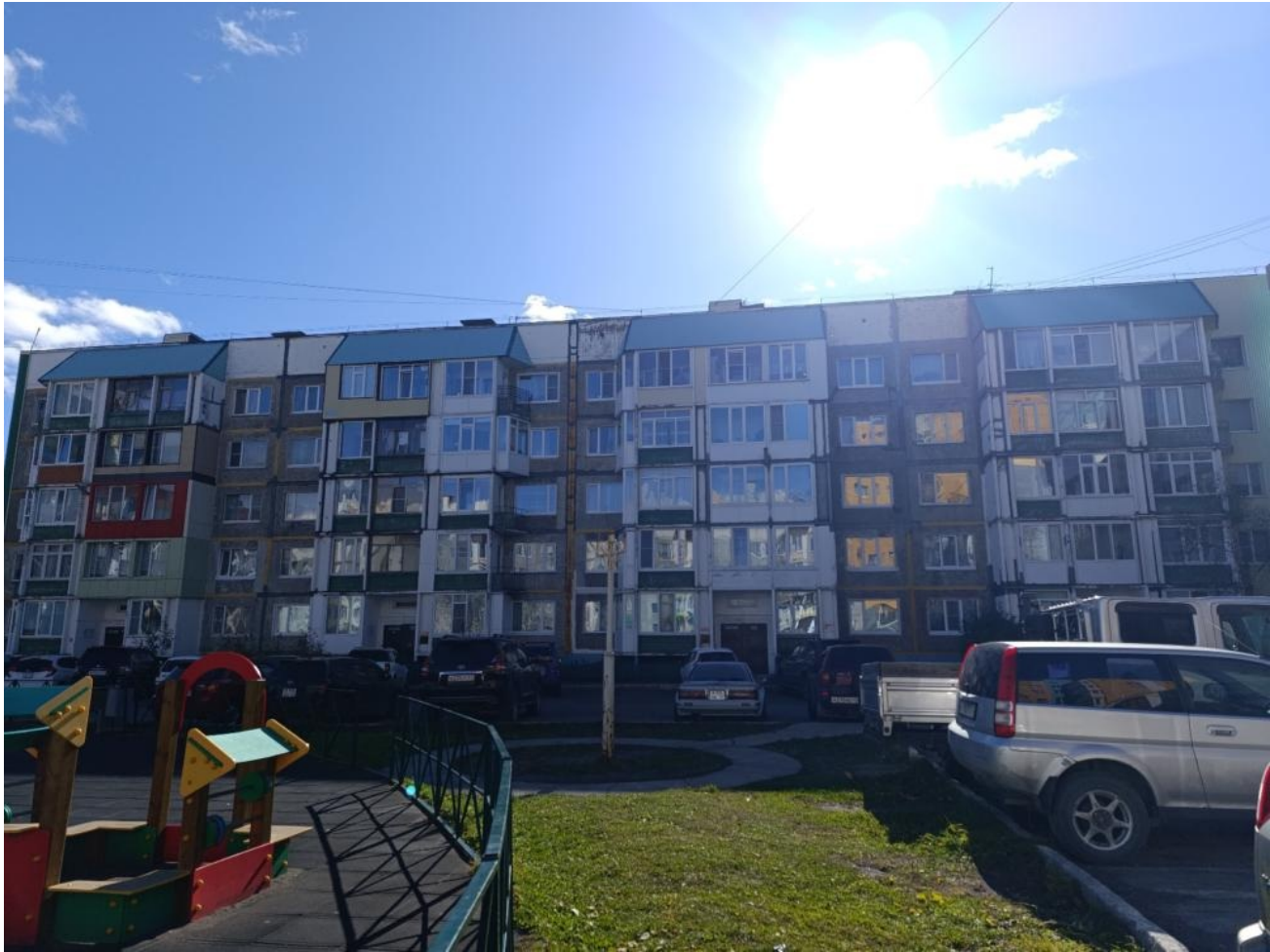
Общий вид здания:
