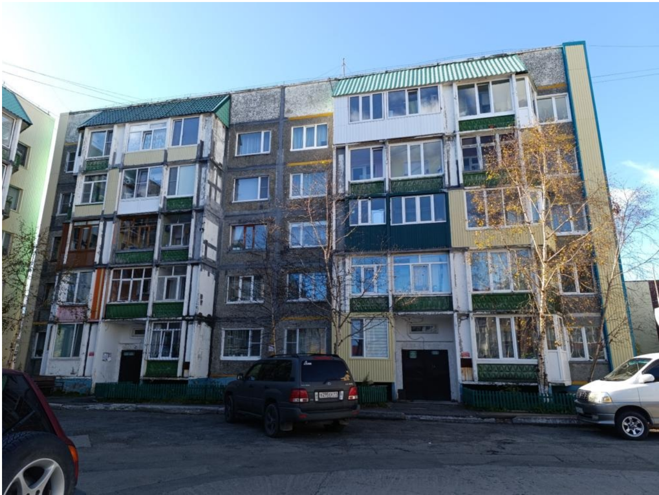
Общий вид здания:
