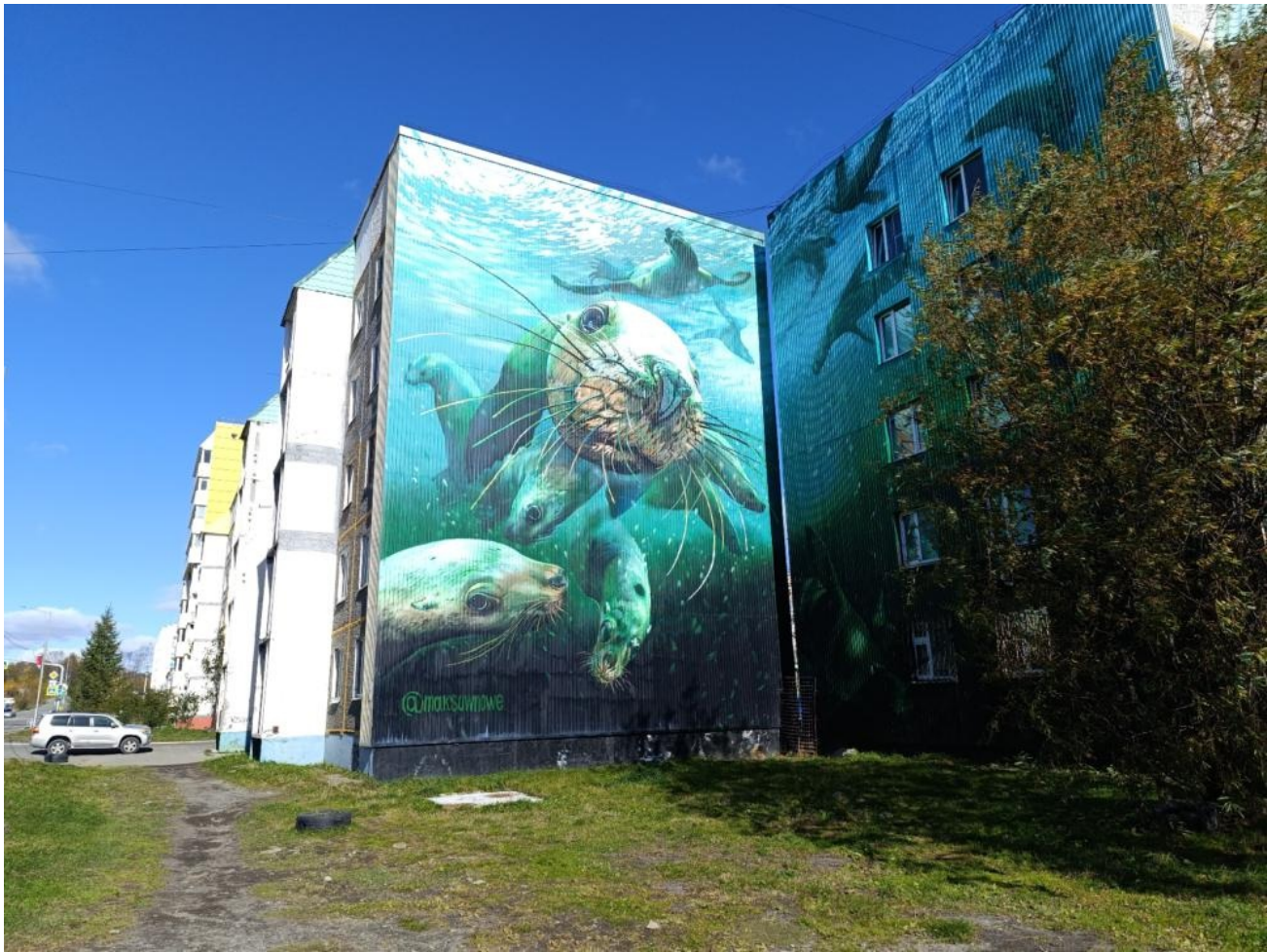
Общий вид здания:
