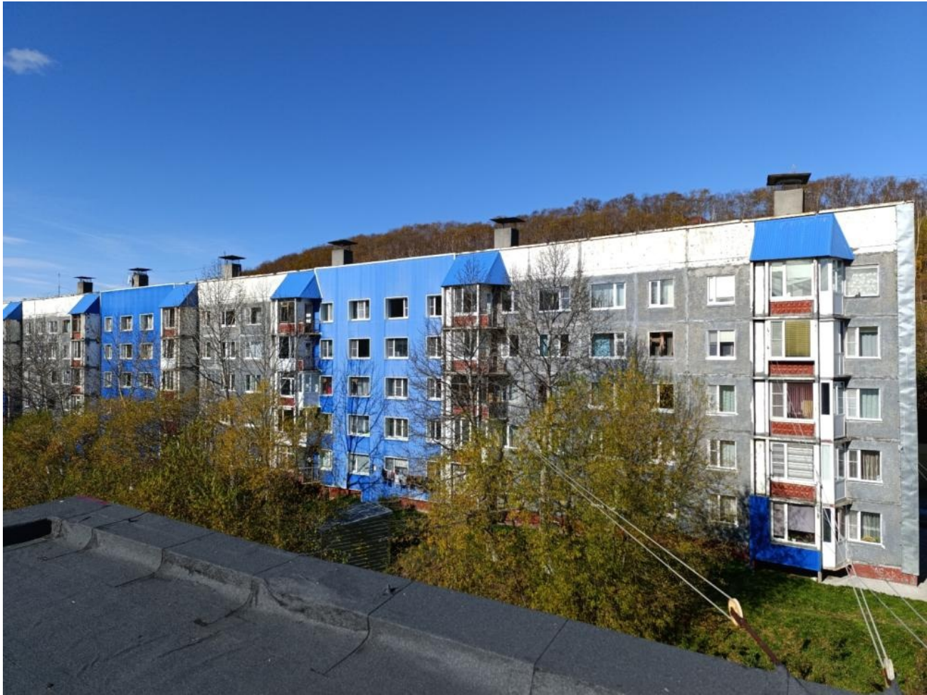
Общий вид здания:
