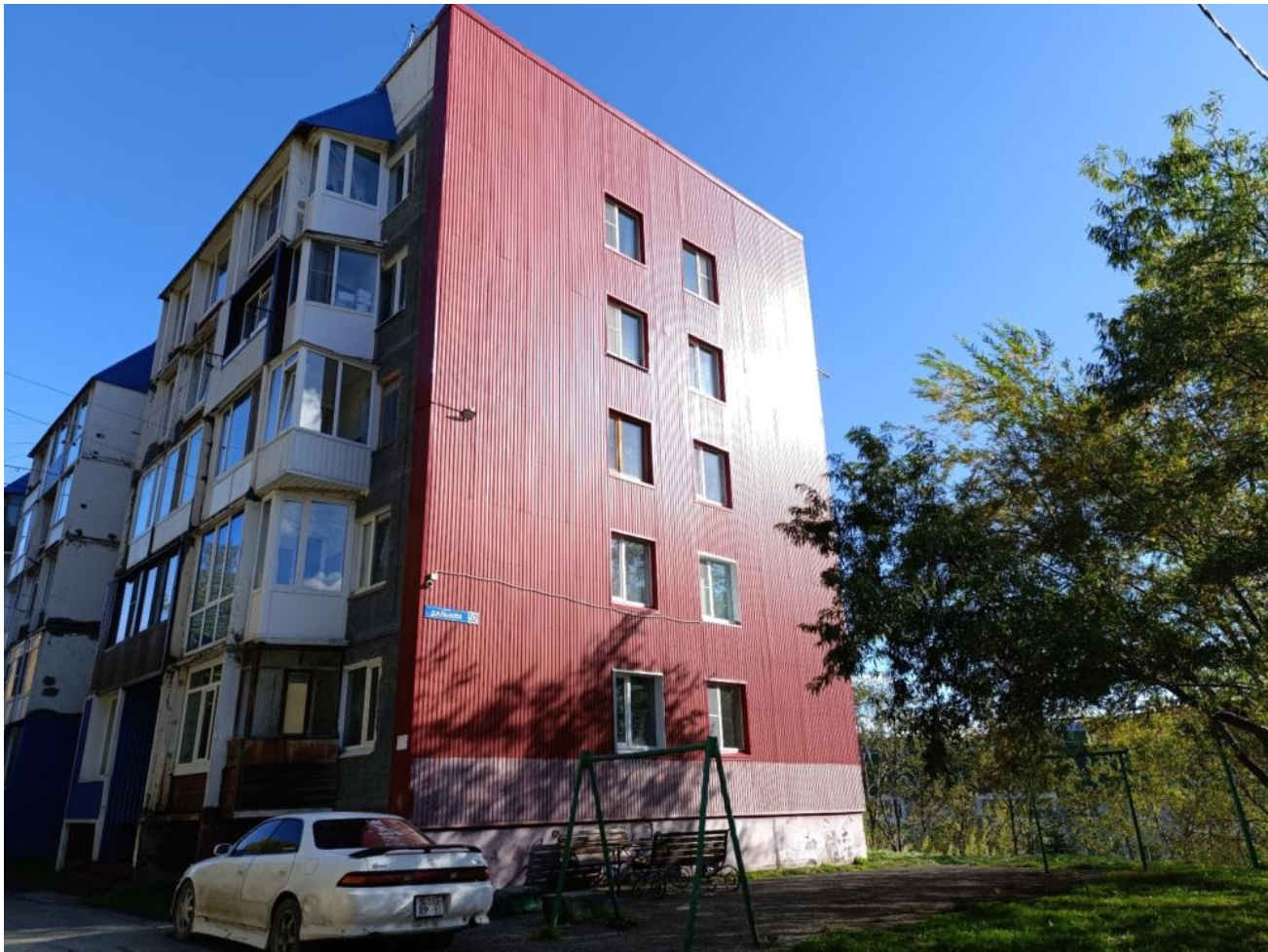
Общий вид здания:
