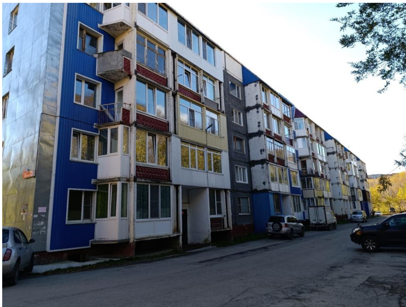
Общий вид здания:
