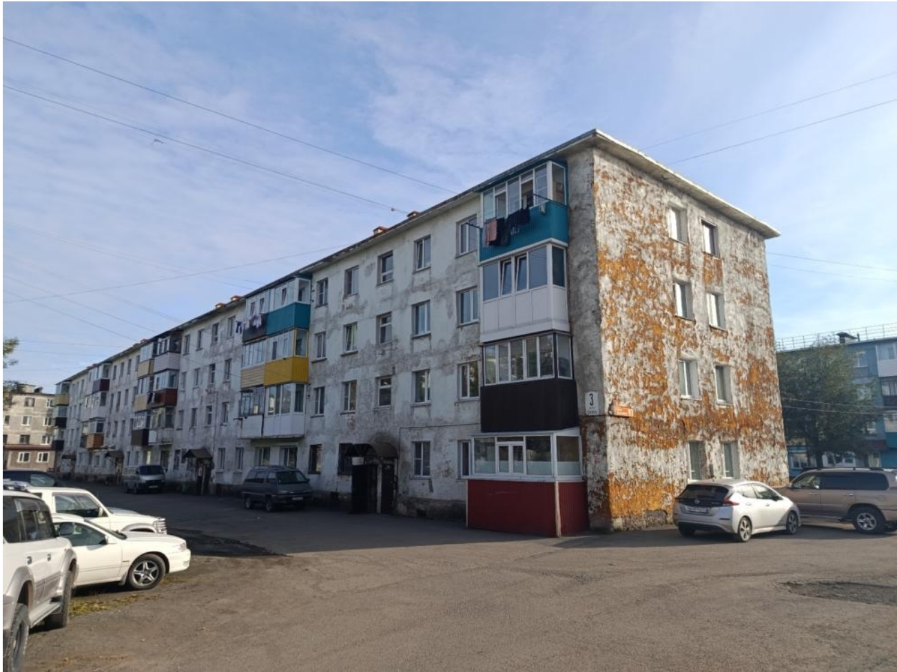
Общий вид здания:
