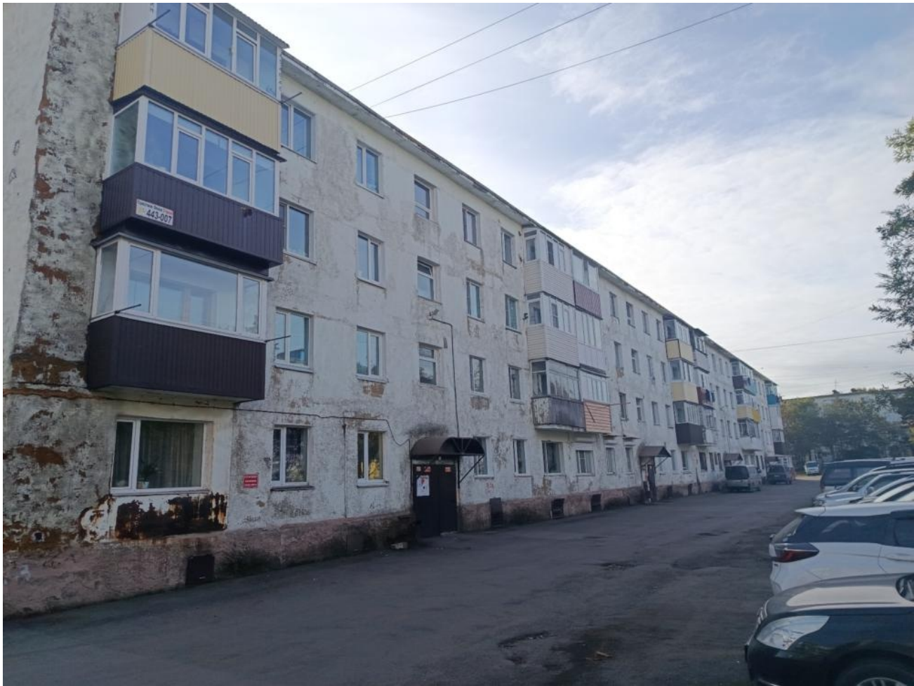
Общий вид здания:
