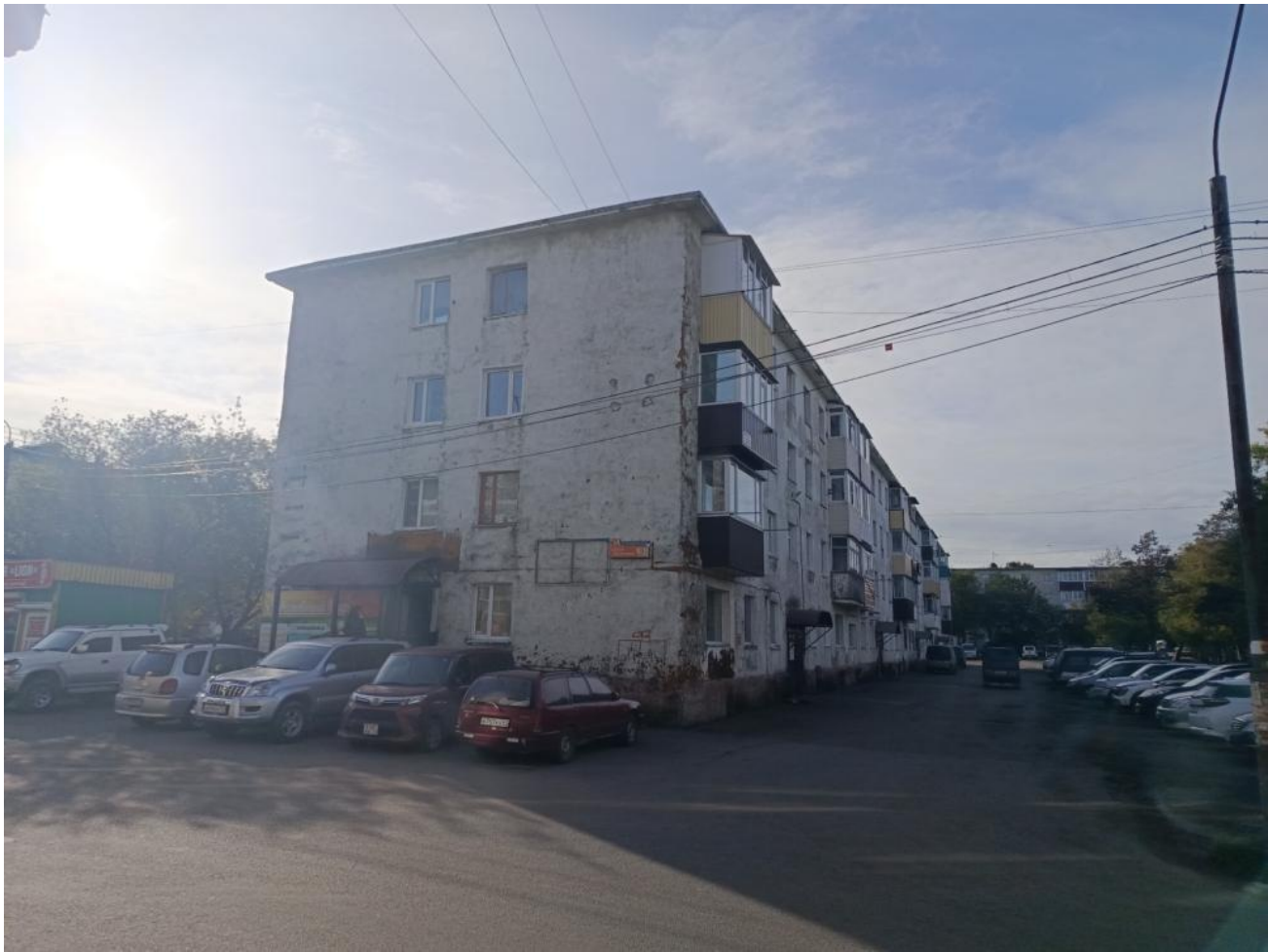
Общий вид здания:
