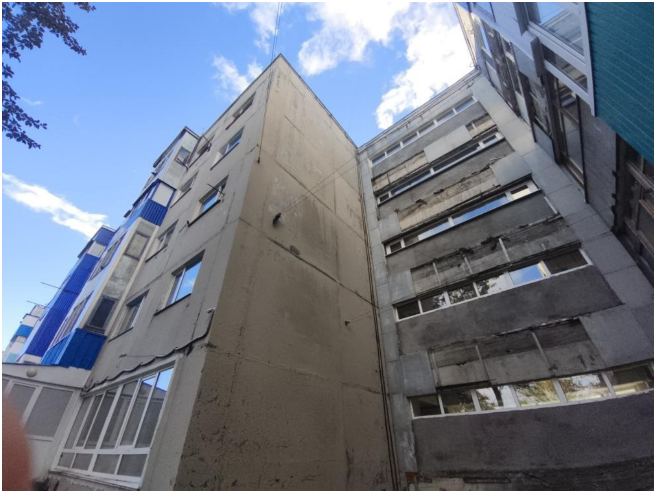
Общий вид здания:
