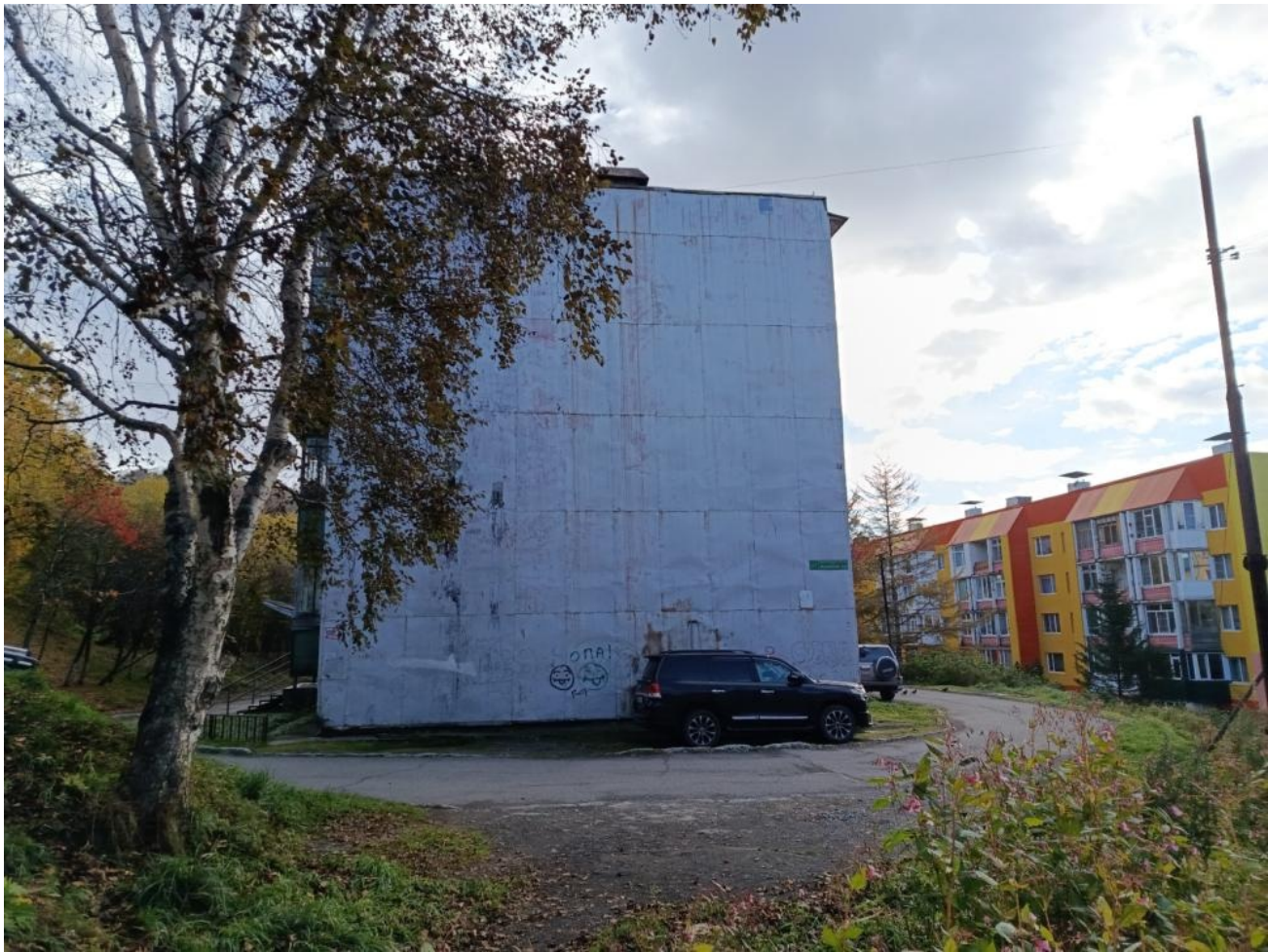
Общий вид здания:
