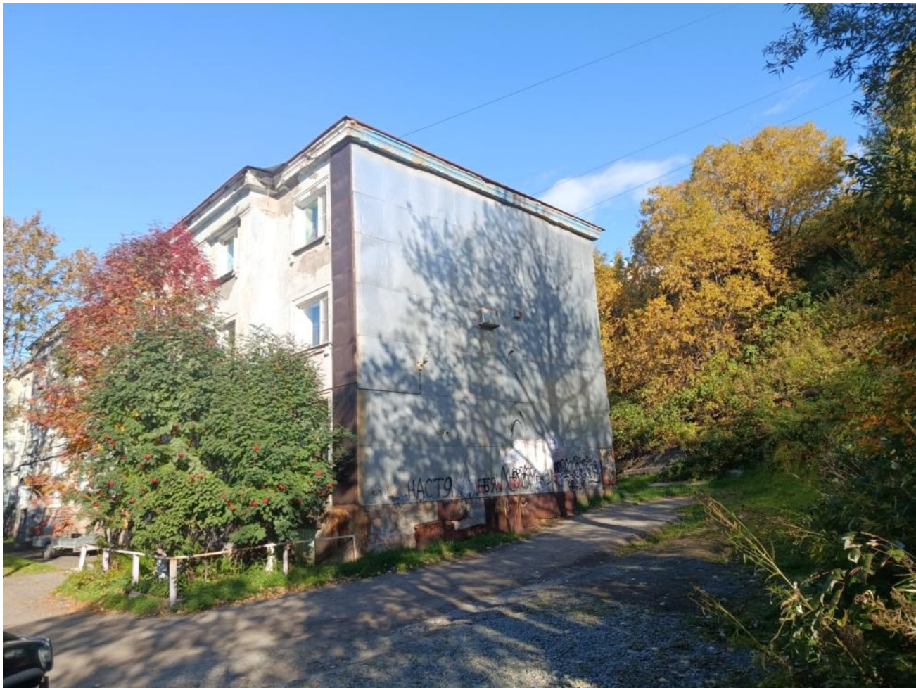
Общий вид здания:
