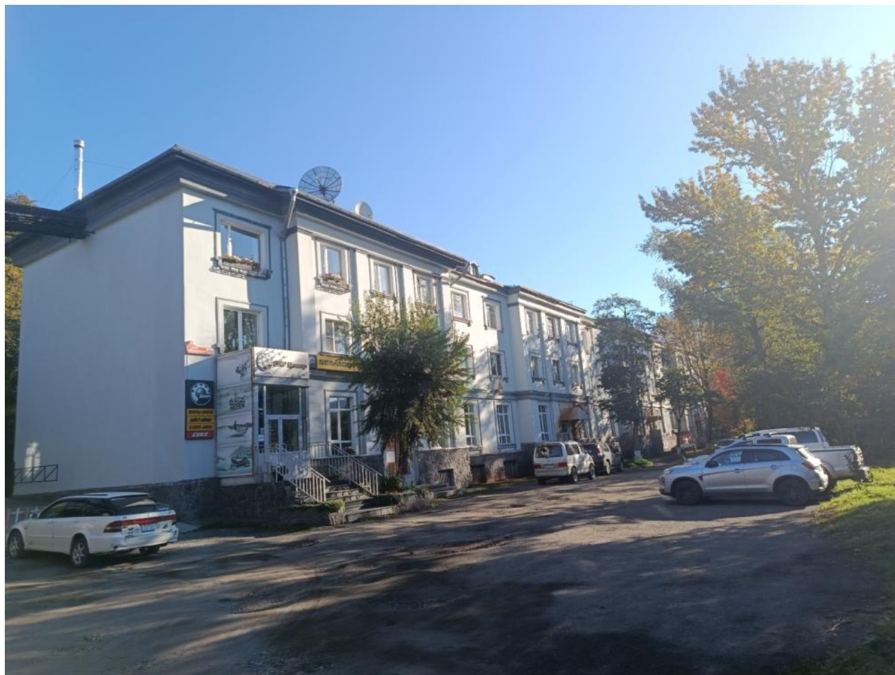
Общий вид здания:
