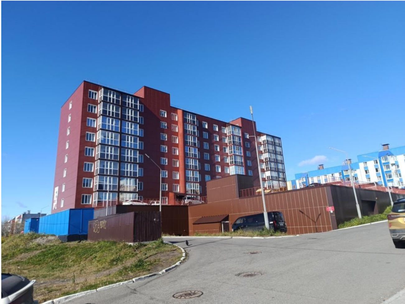
Общий вид здания:
