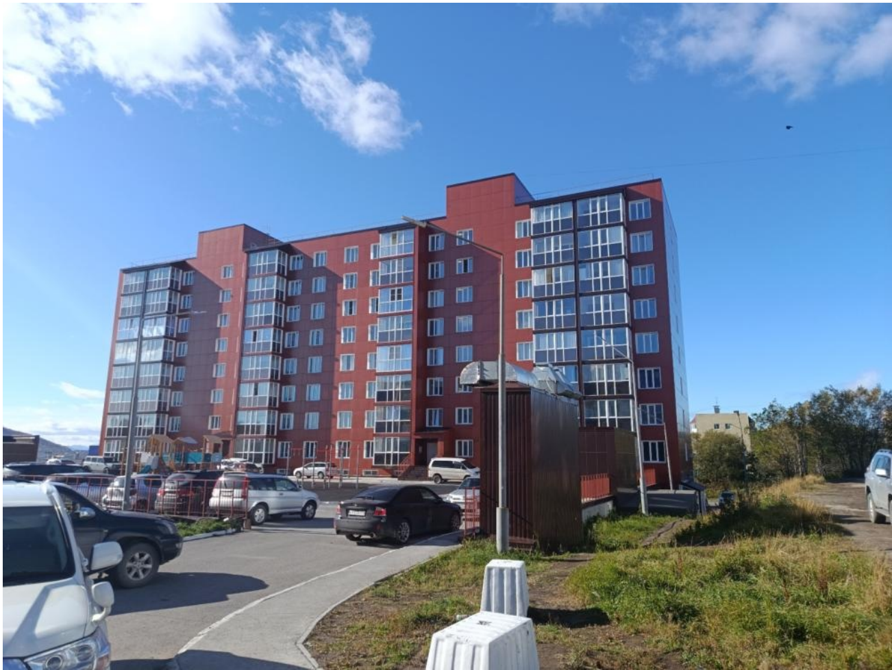
Общий вид здания:
