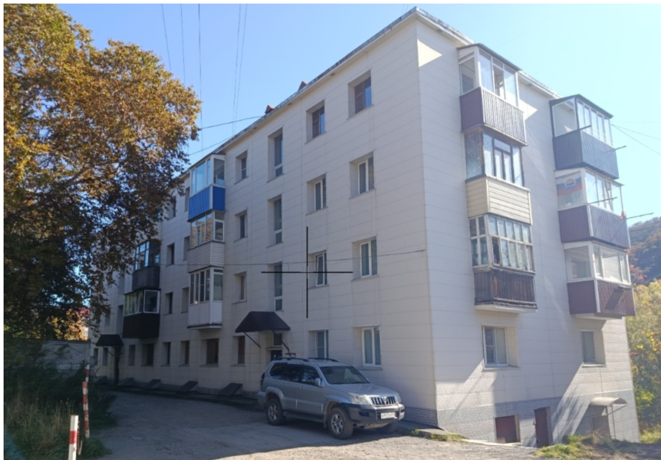
Общий вид здания:
