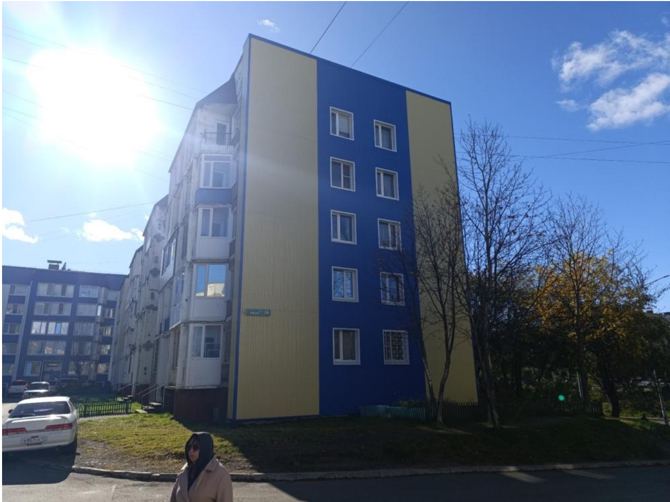
Общий вид здания:
