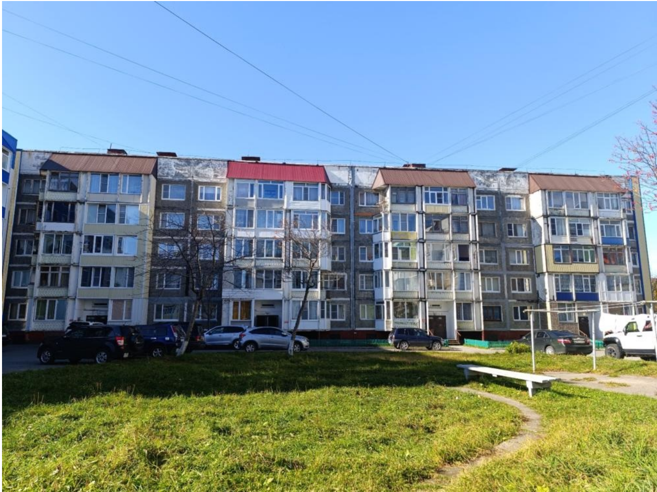
Общий вид здания:
