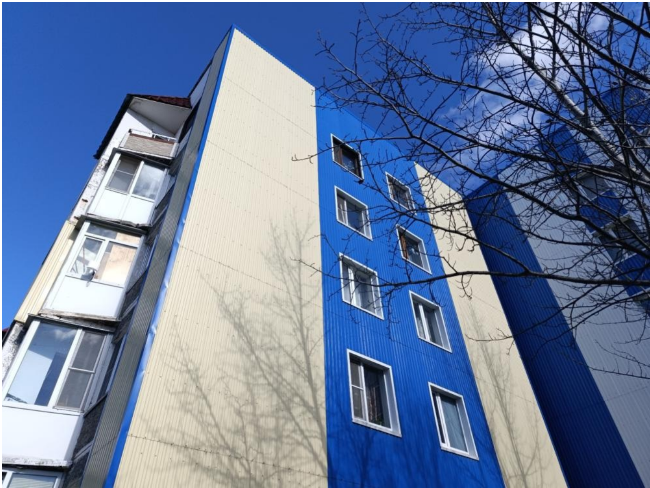
Общий вид здания:
