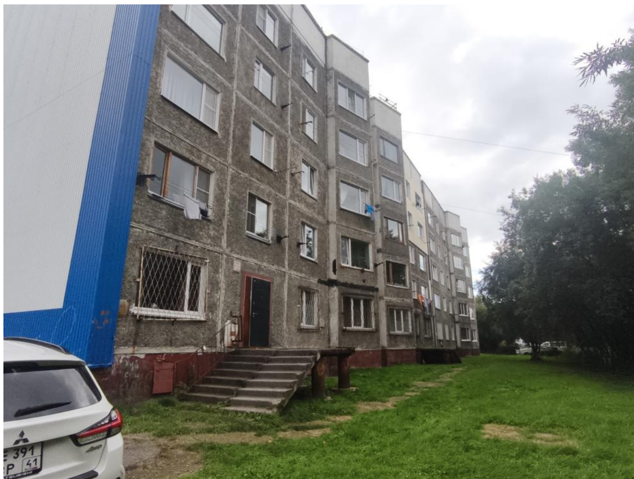
Общий вид здания:
