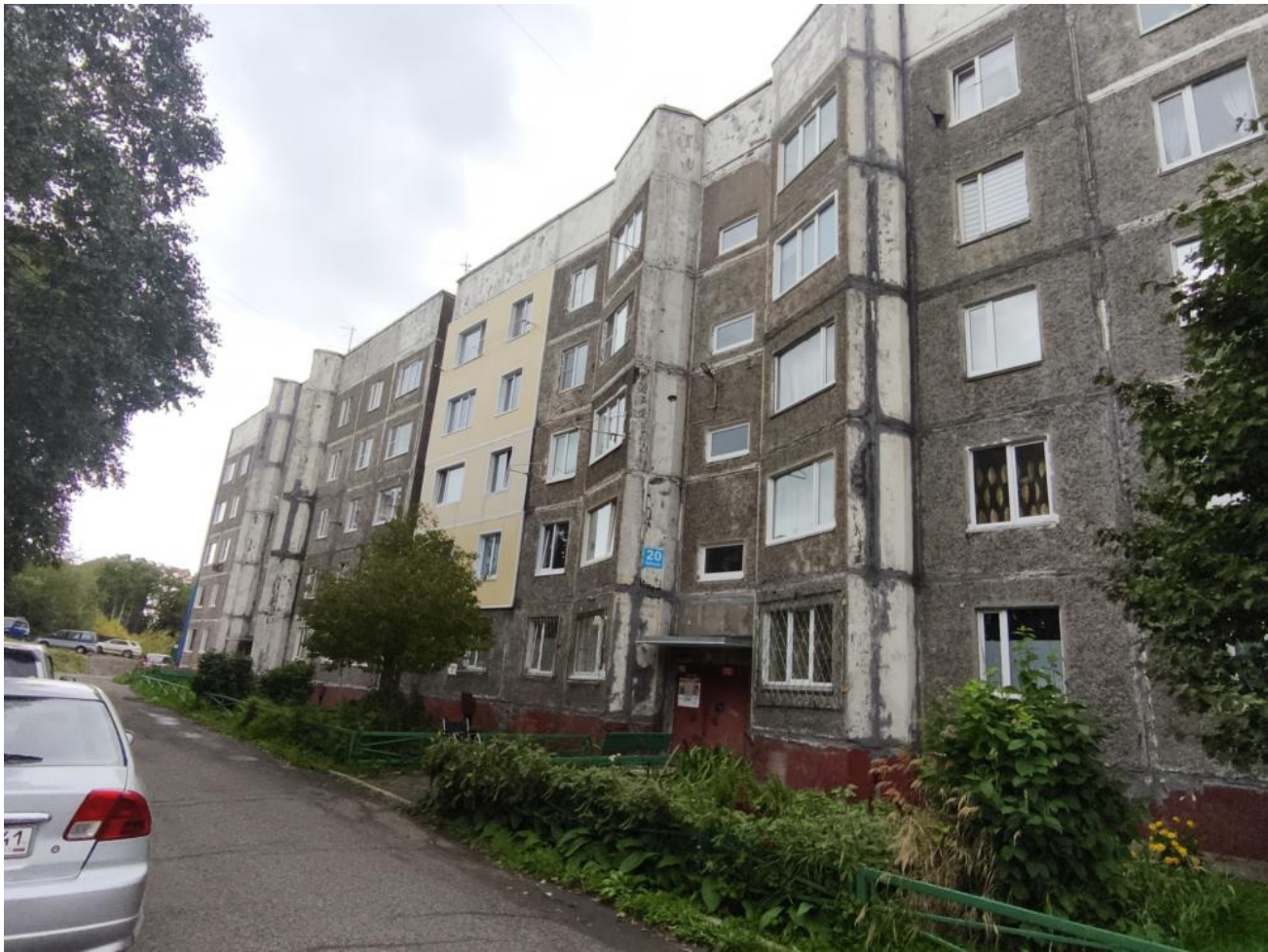
Общий вид здания:
