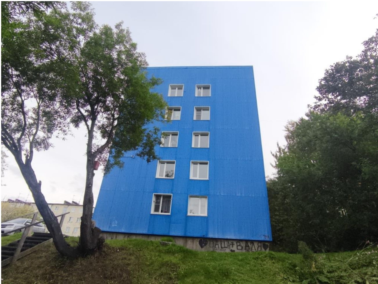
Общий вид здания:
