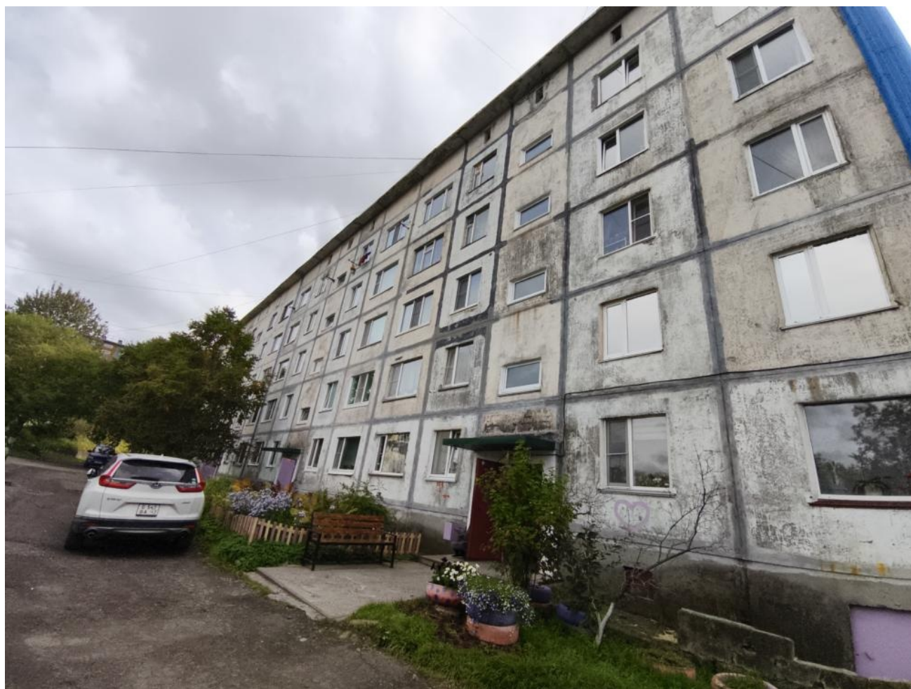
Общий вид здания:
