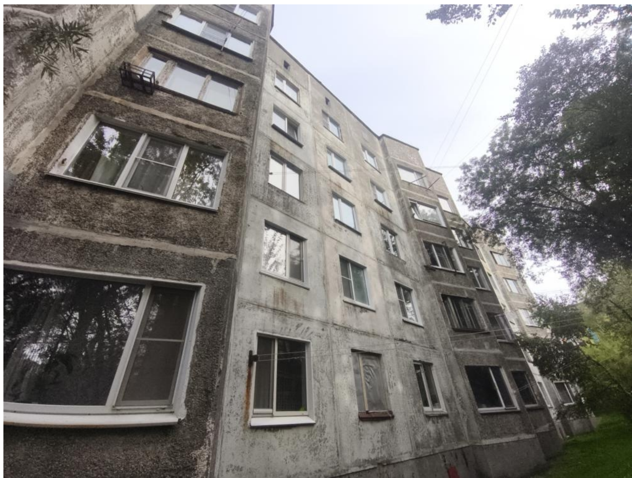
Общий вид здания:
