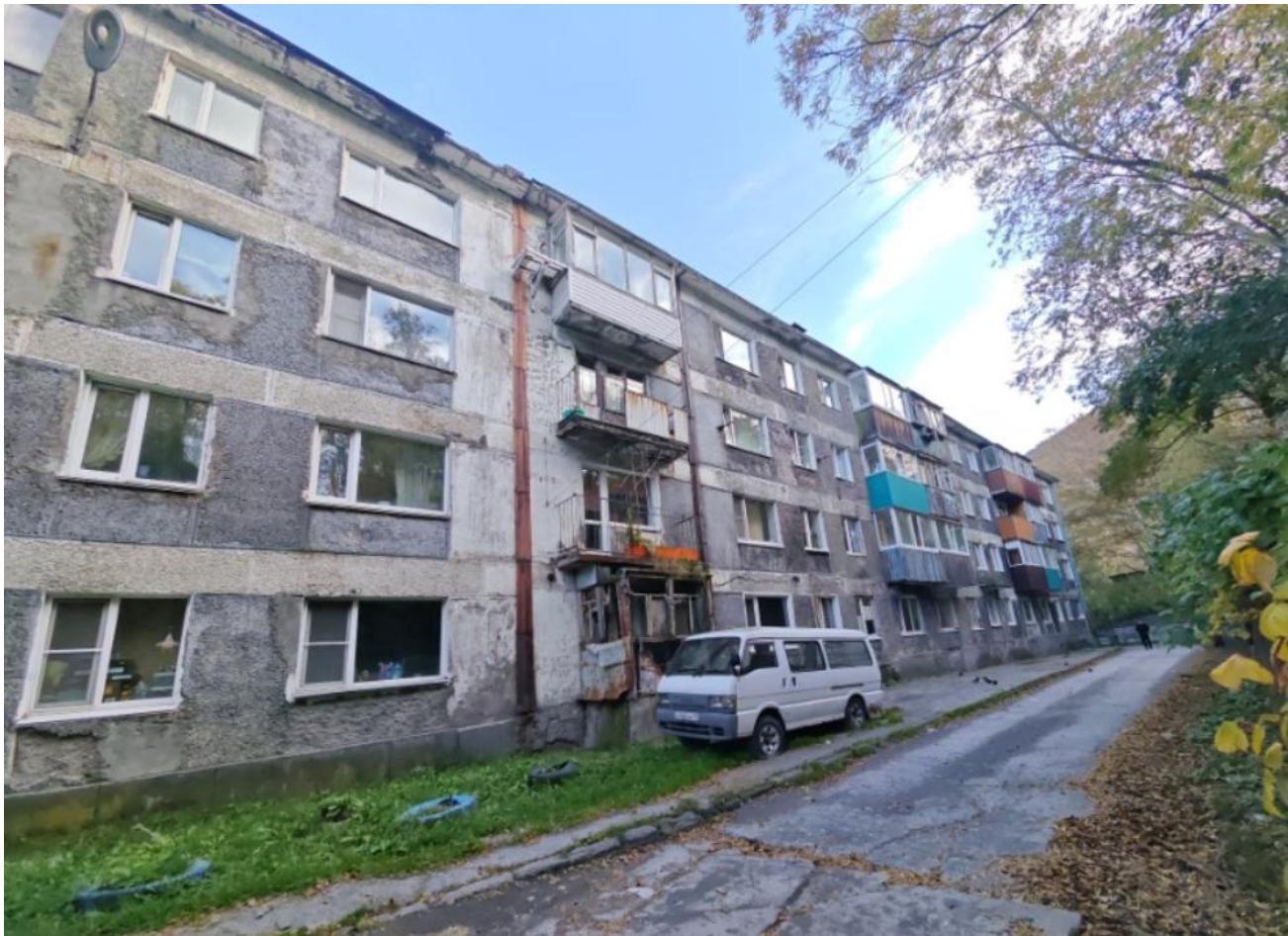
Общий вид здания:
