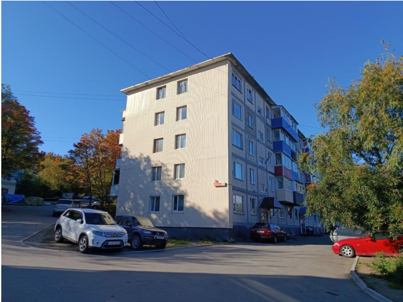
Общий вид здания:
