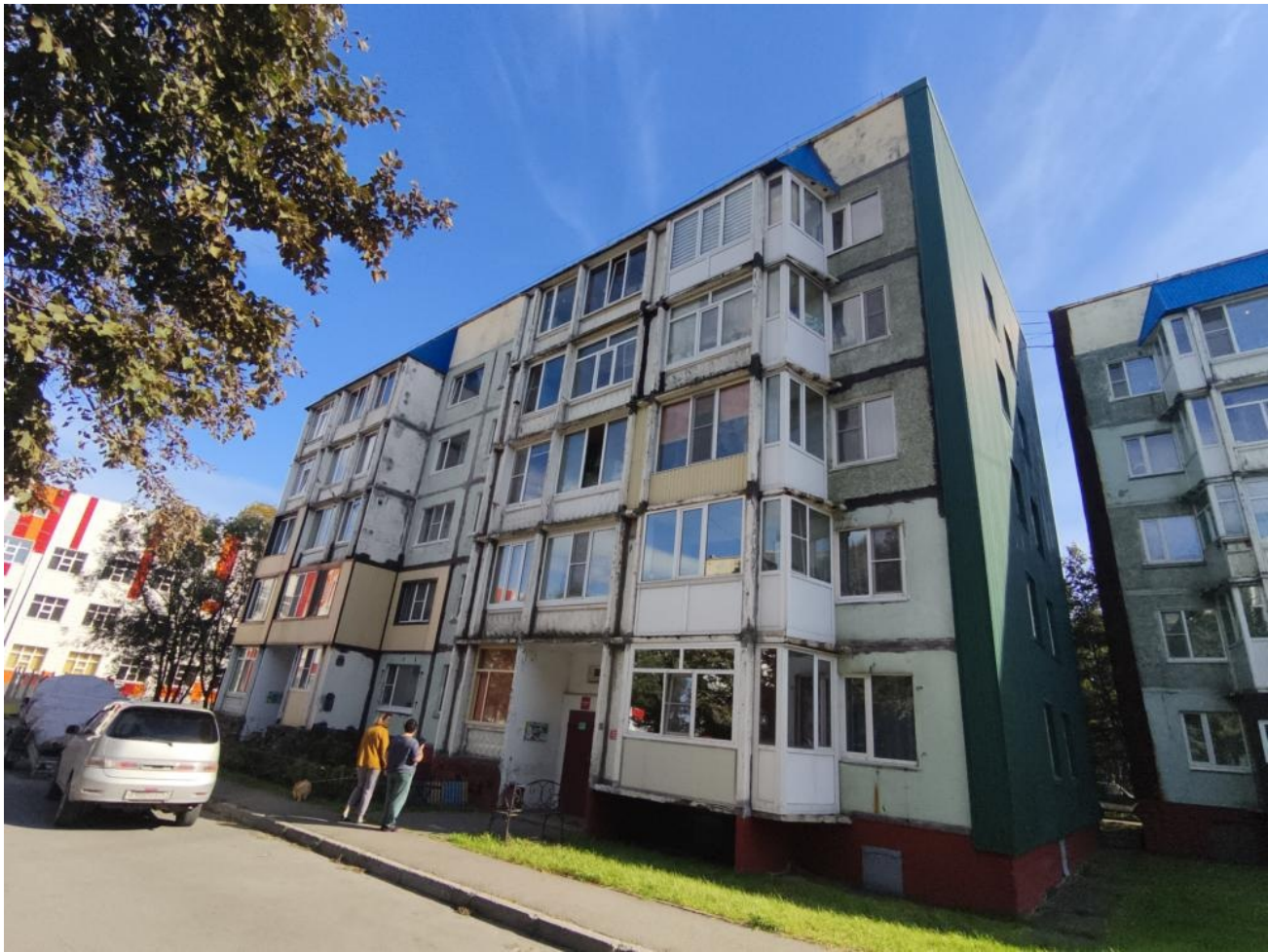
Общий вид здания:
