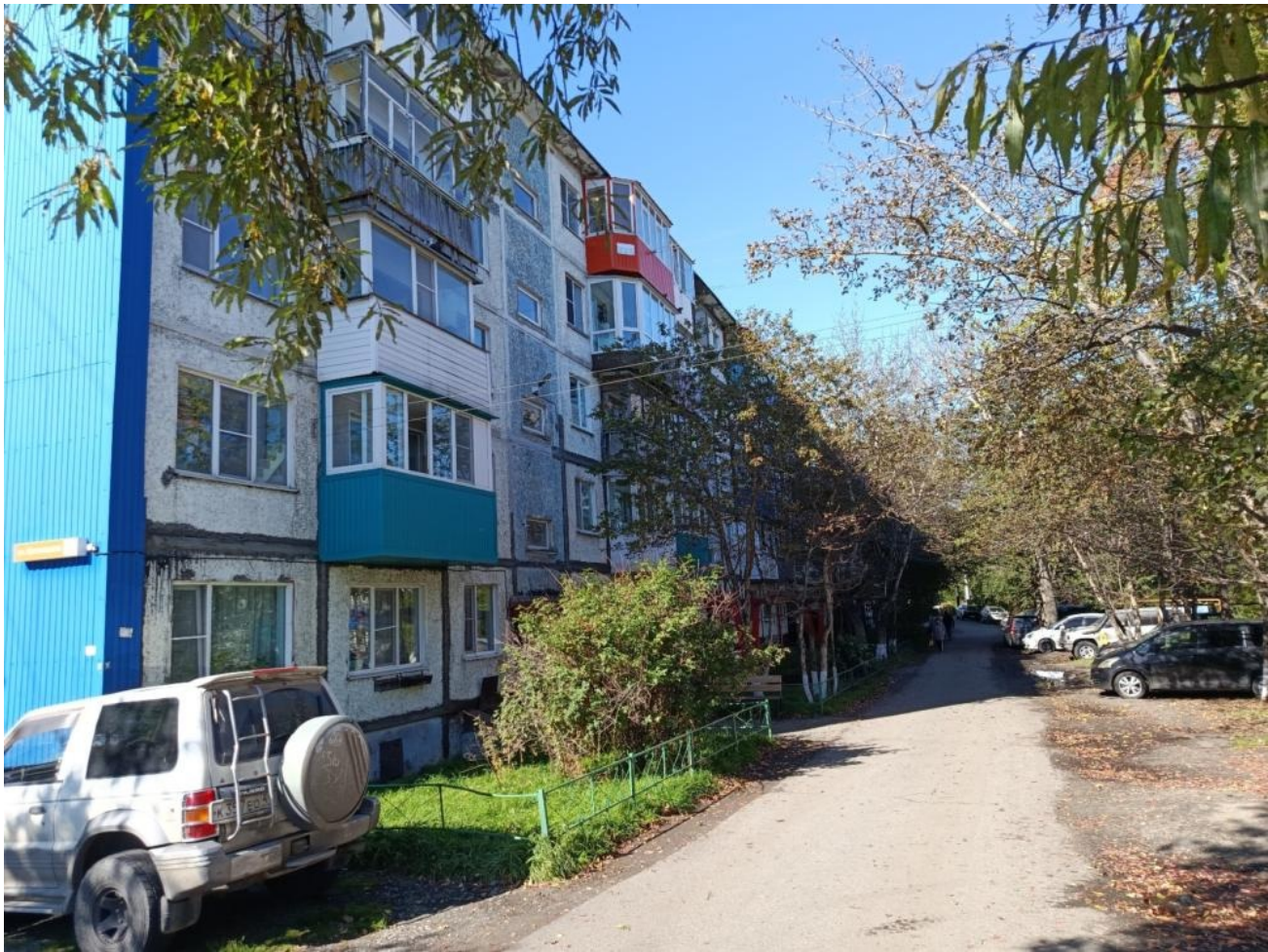
Общий вид здания:
