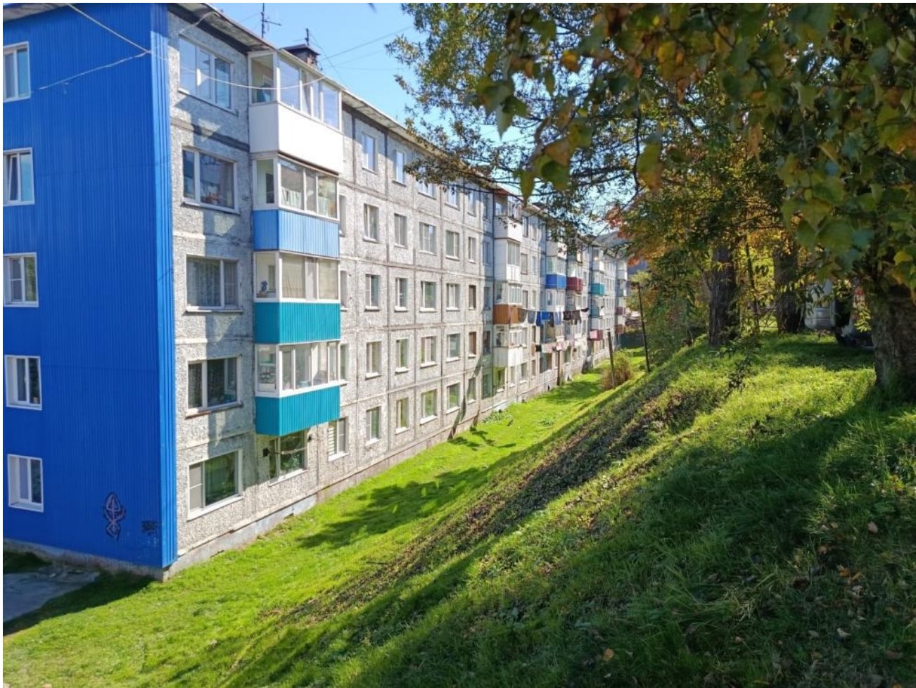
Общий вид здания:
