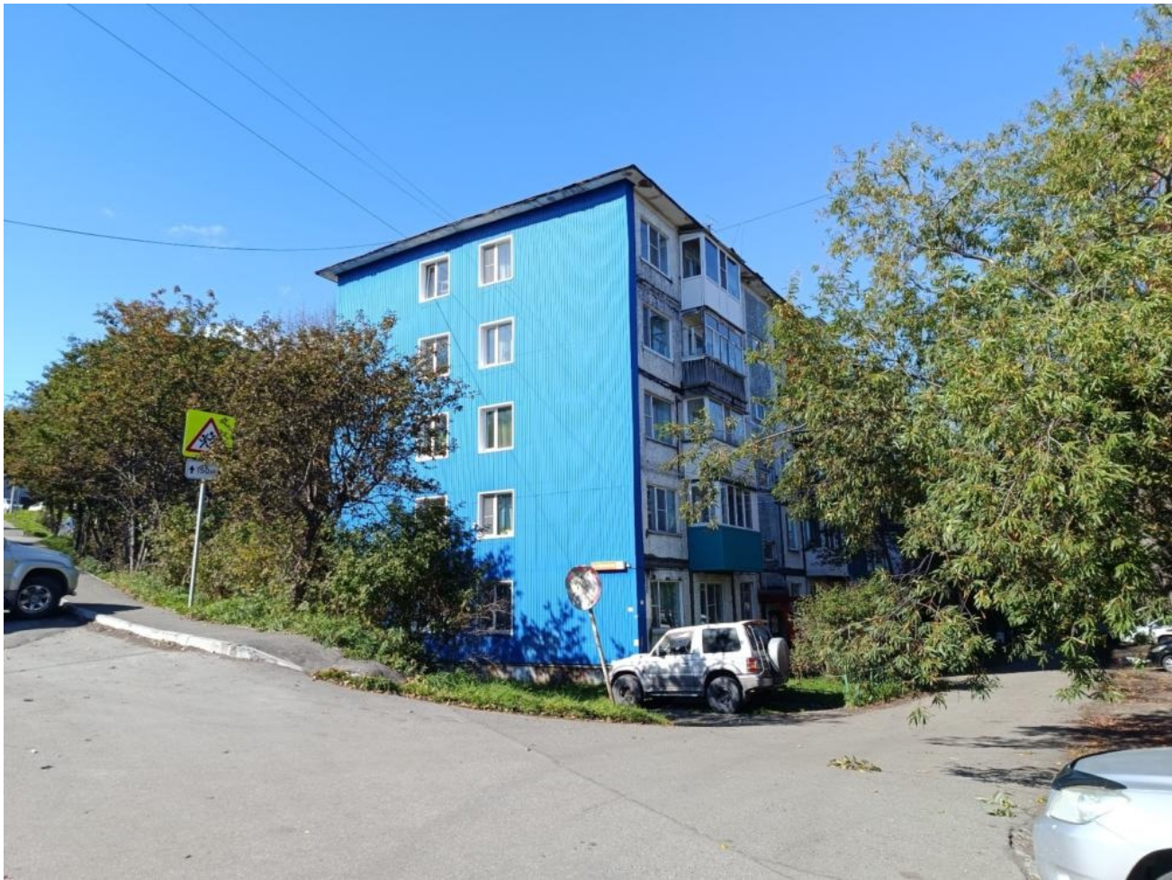
Общий вид здания:
