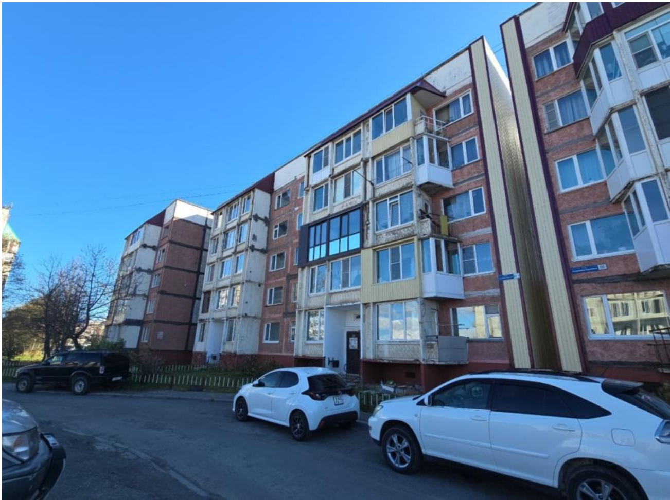
Общий вид здания:
