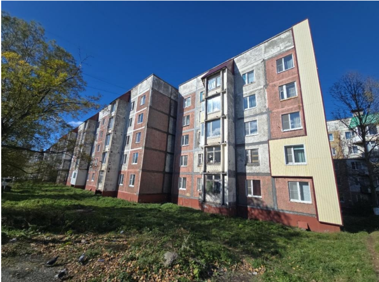
Общий вид здания:
