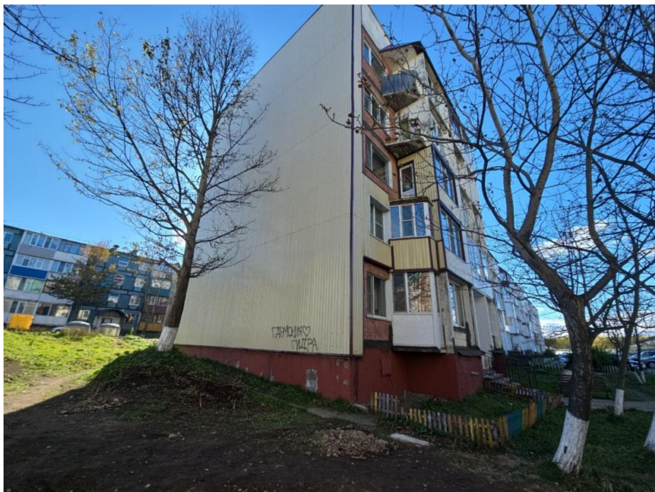
Общий вид здания:
