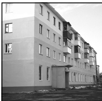
Жилфонд 4 объём ремонтных работ будет увеличен
