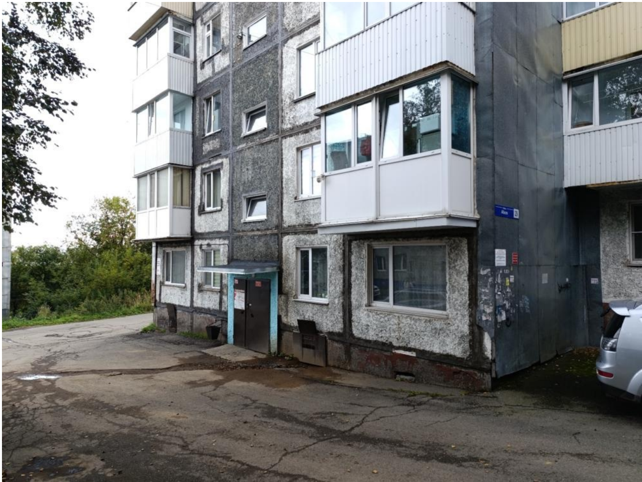
Общий вид здания:
