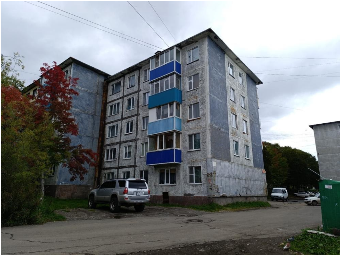
Общий вид здания:
