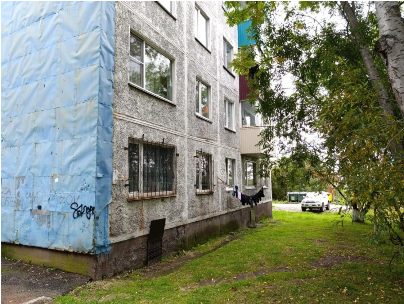
Общий вид здания:
