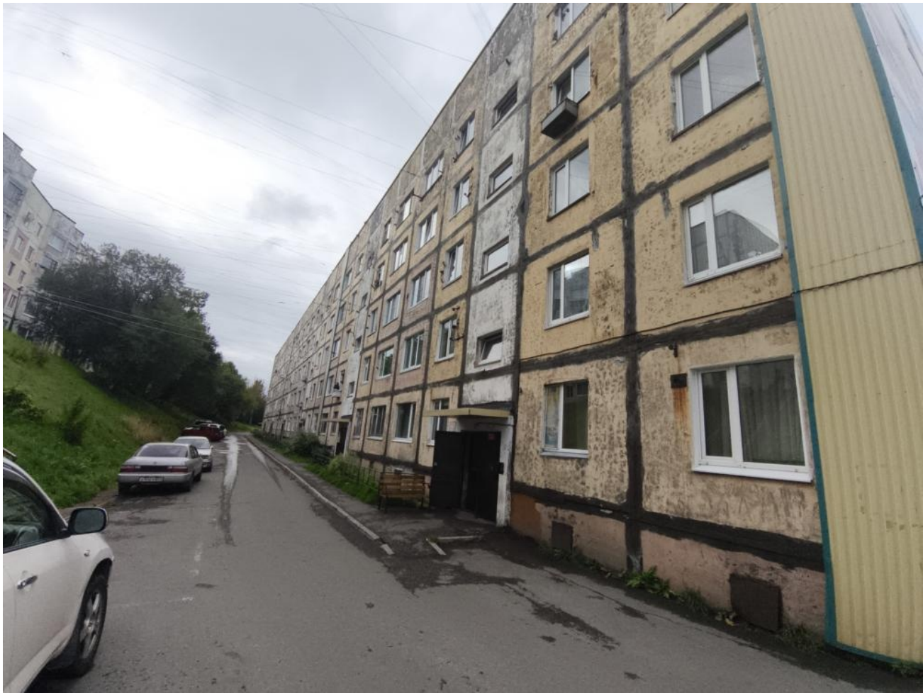
Общий вид здания:
