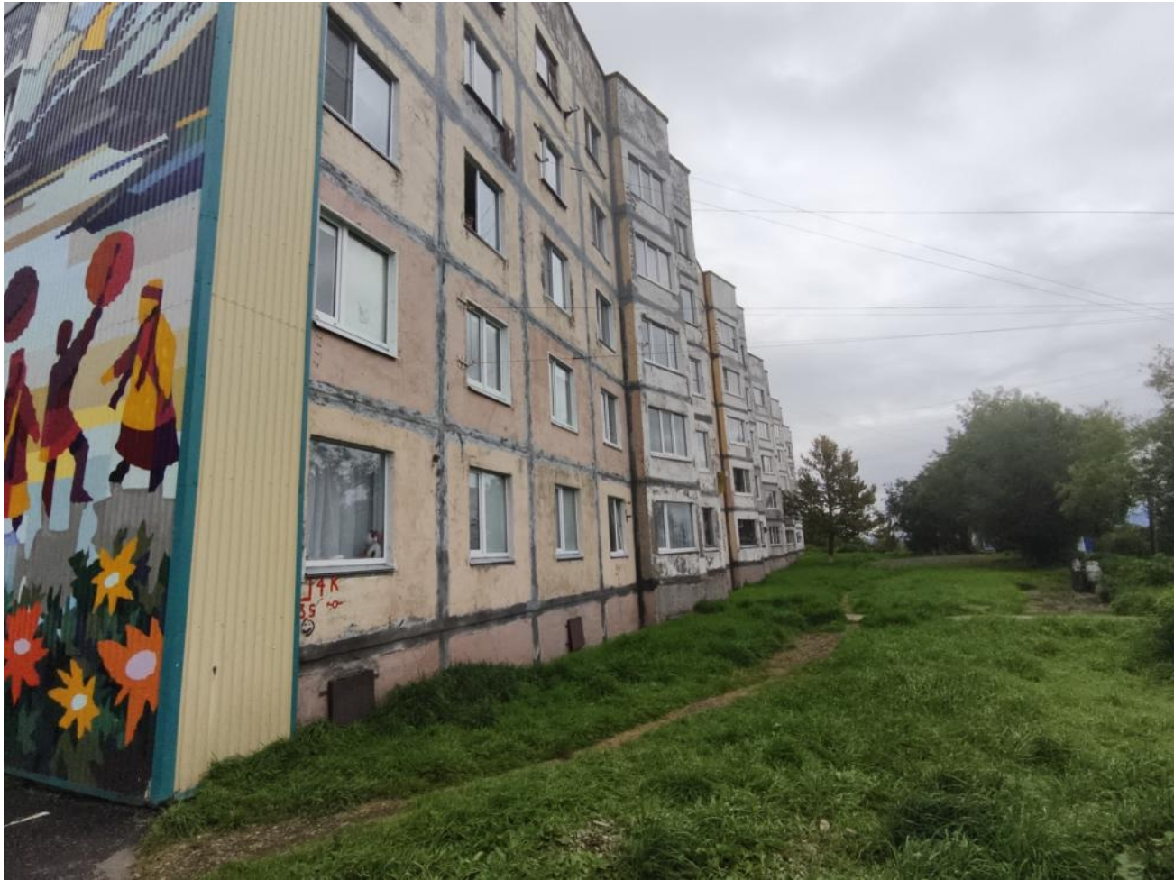
Общий вид здания:
