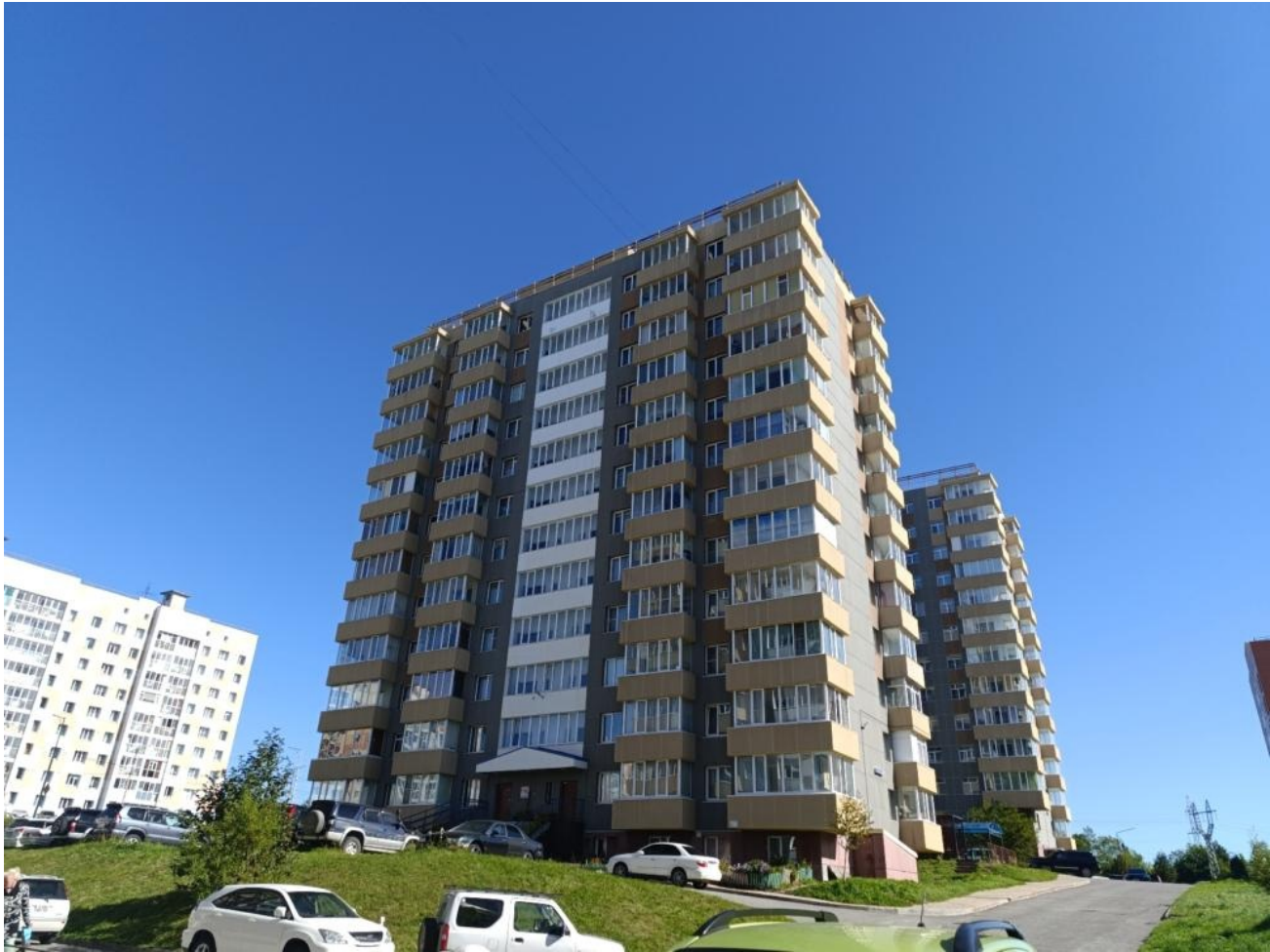
Общий вид здания:
