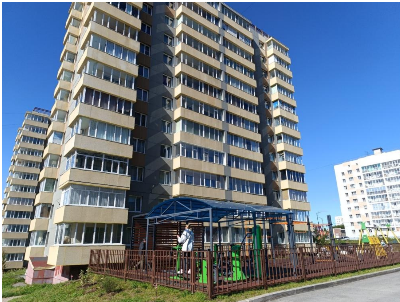
Общий вид здания:
