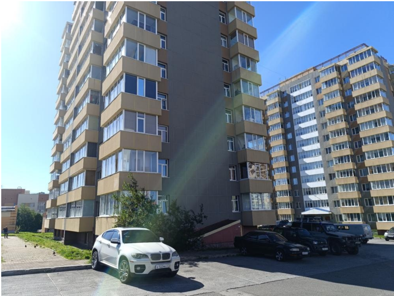
Общий вид здания:
