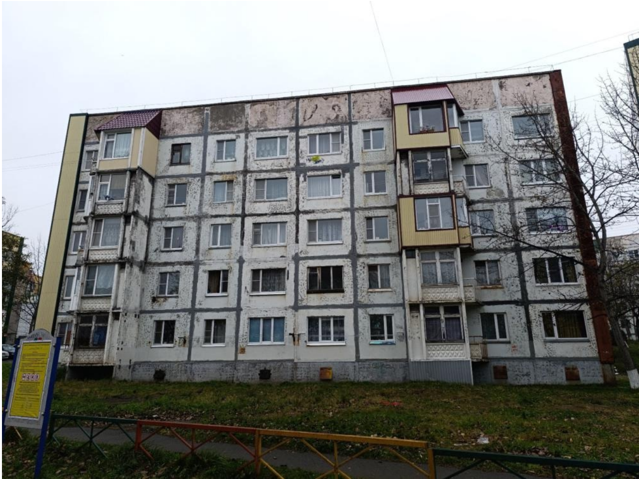
Общий вид здания:
