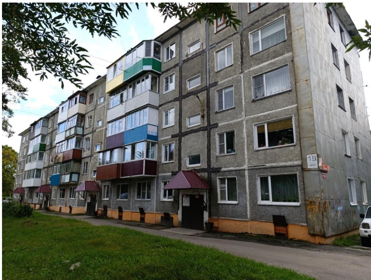
Общий вид здания:
