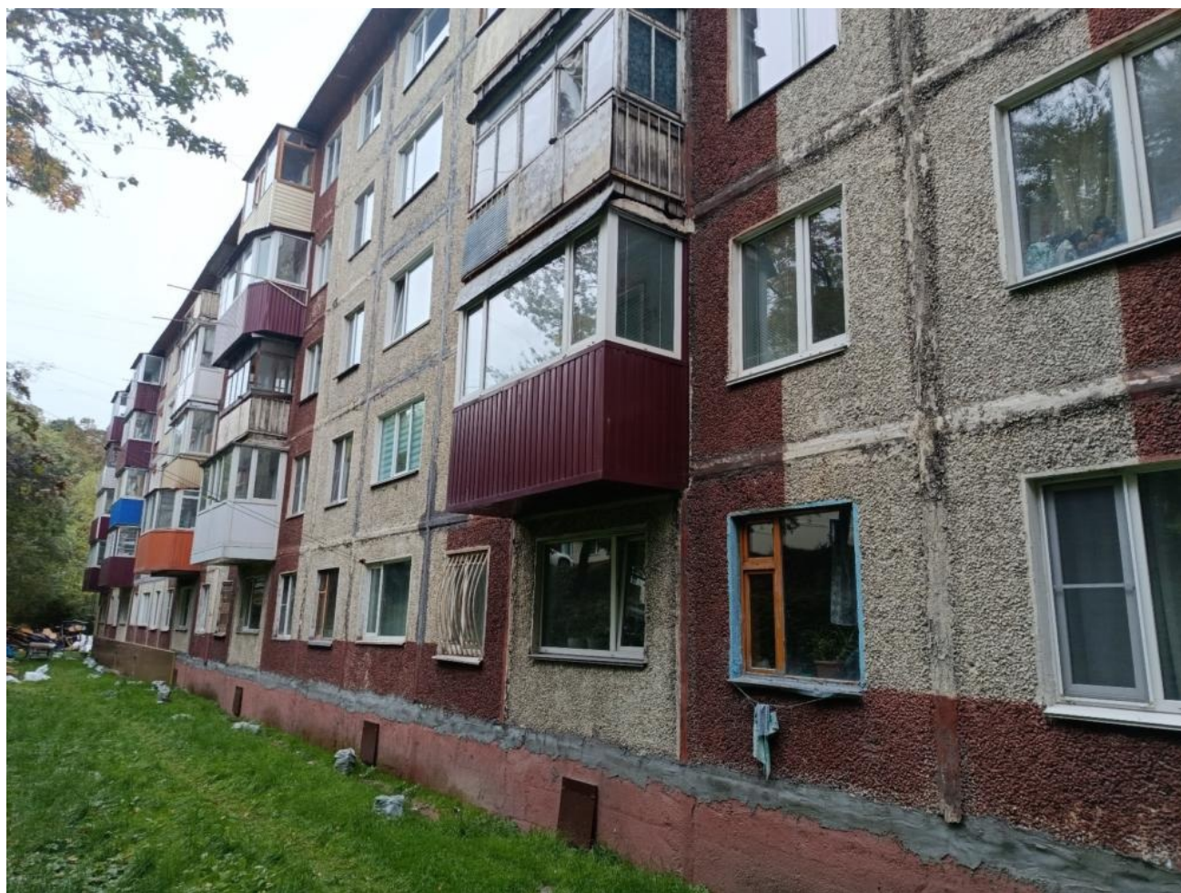
Общий вид здания:
