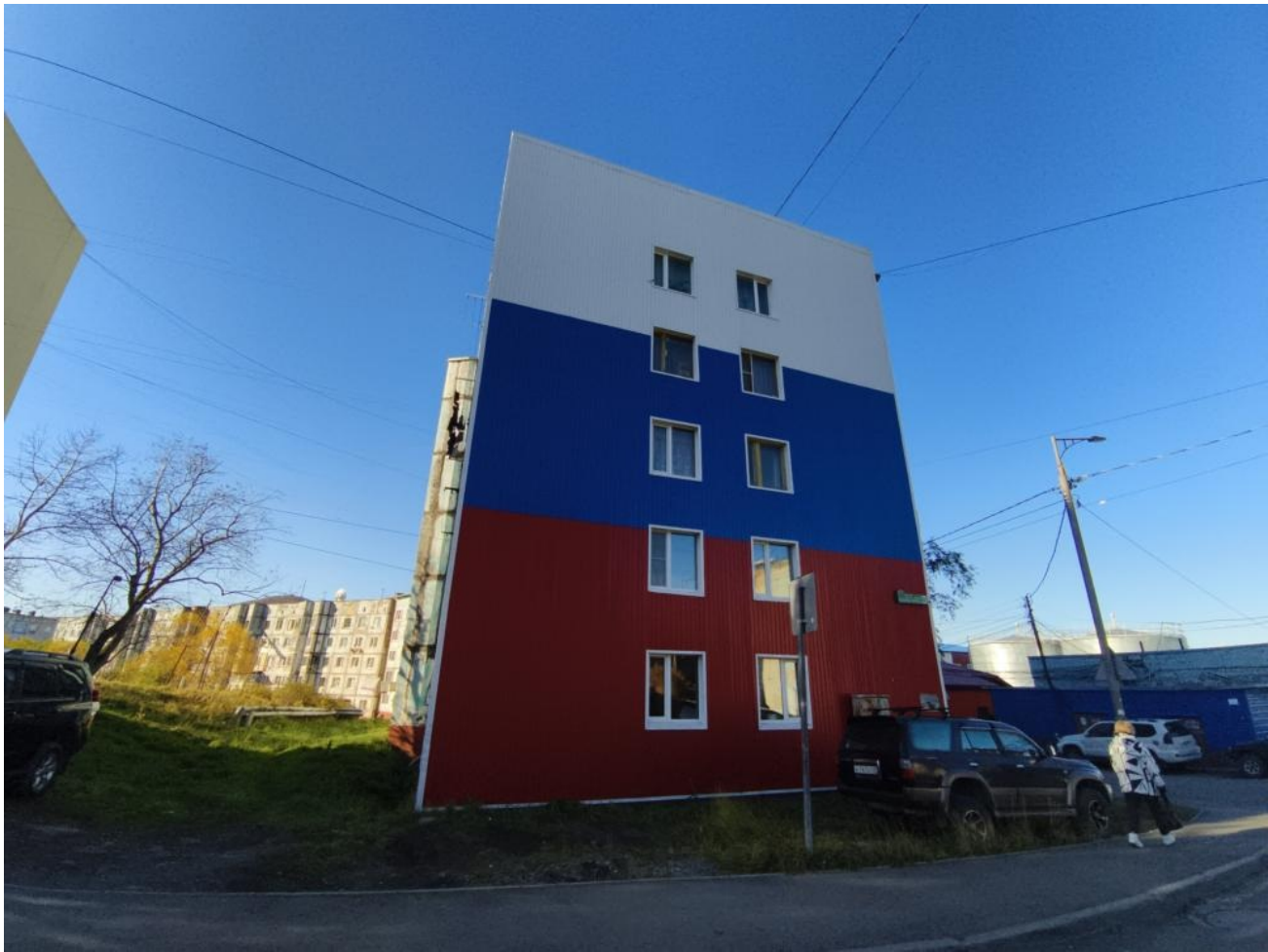
Общий вид здания:
