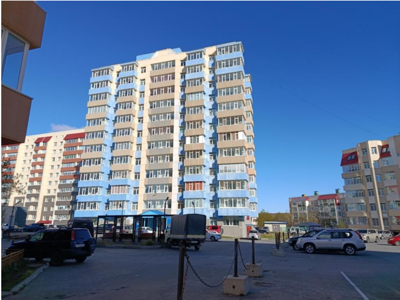
Общий вид здания:
