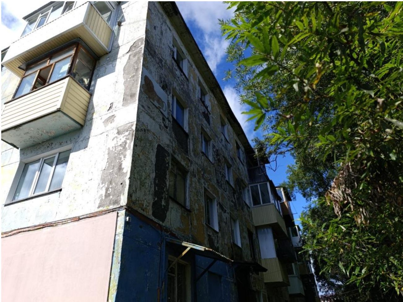
Общий вид здания:
