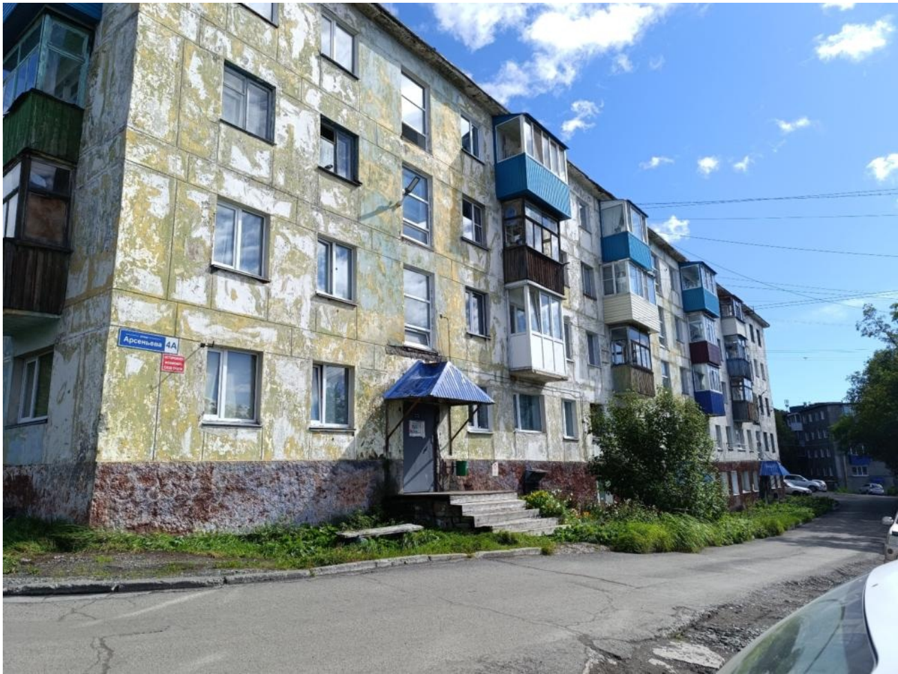
Общий вид здания:
