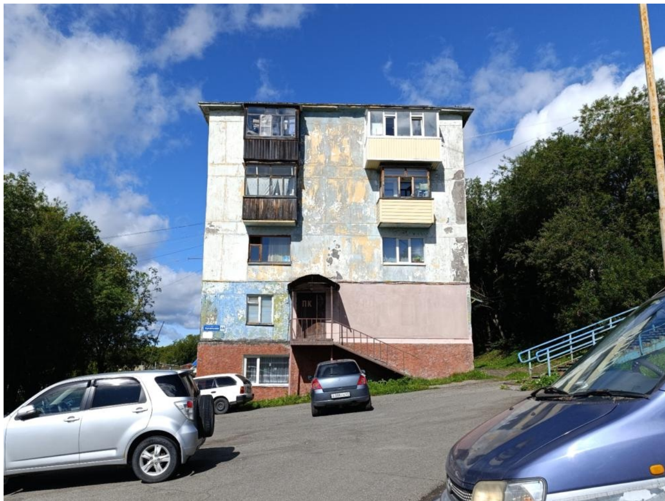
Общий вид здания:
