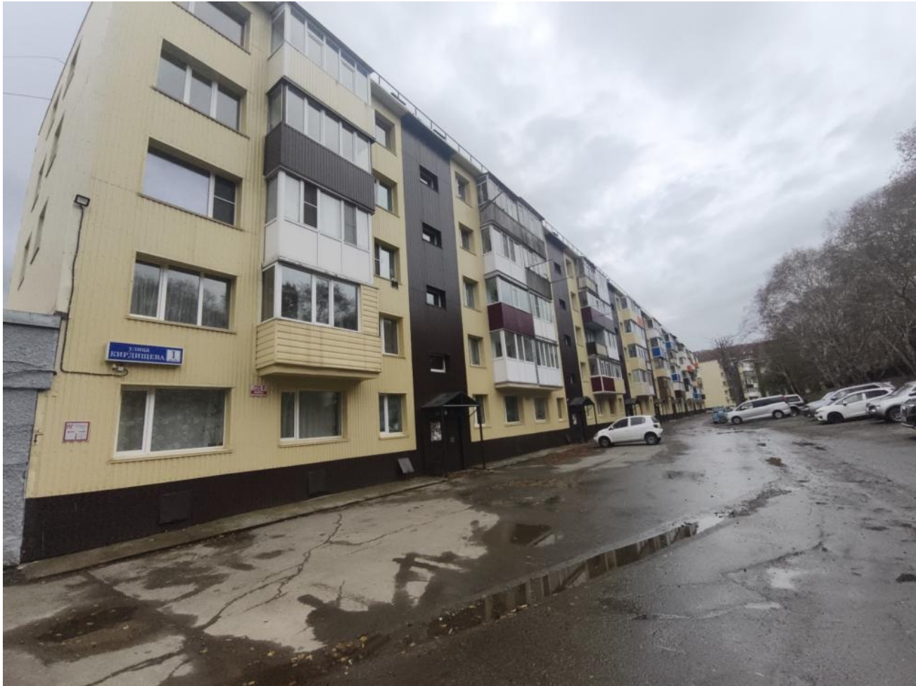
Общий вид здания:
