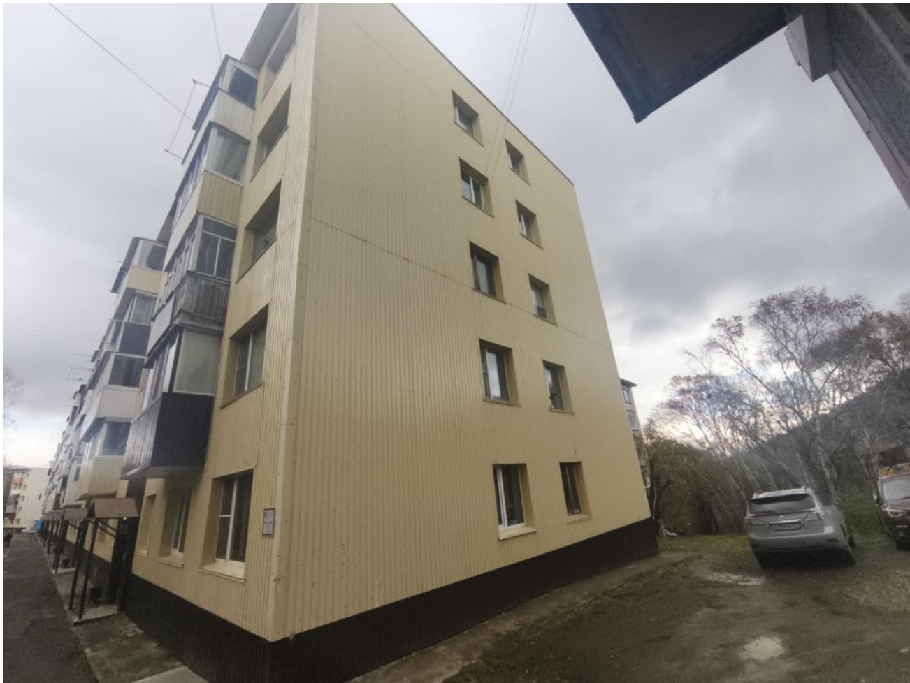
Общий вид здания:
