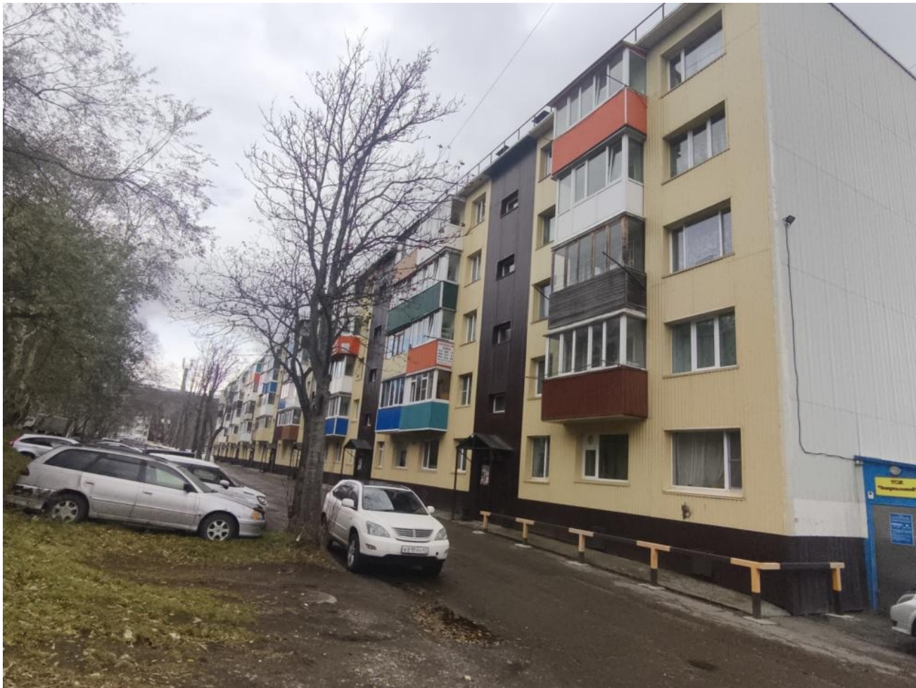
Общий вид здания:
