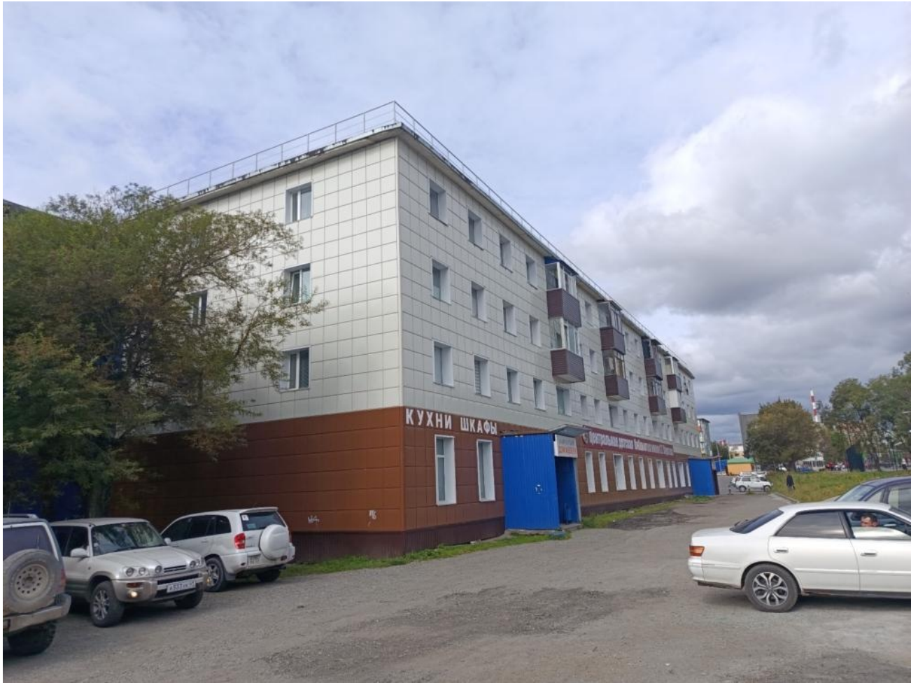
Общий вид здания:
