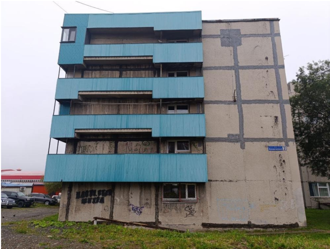
Общий вид здания:
